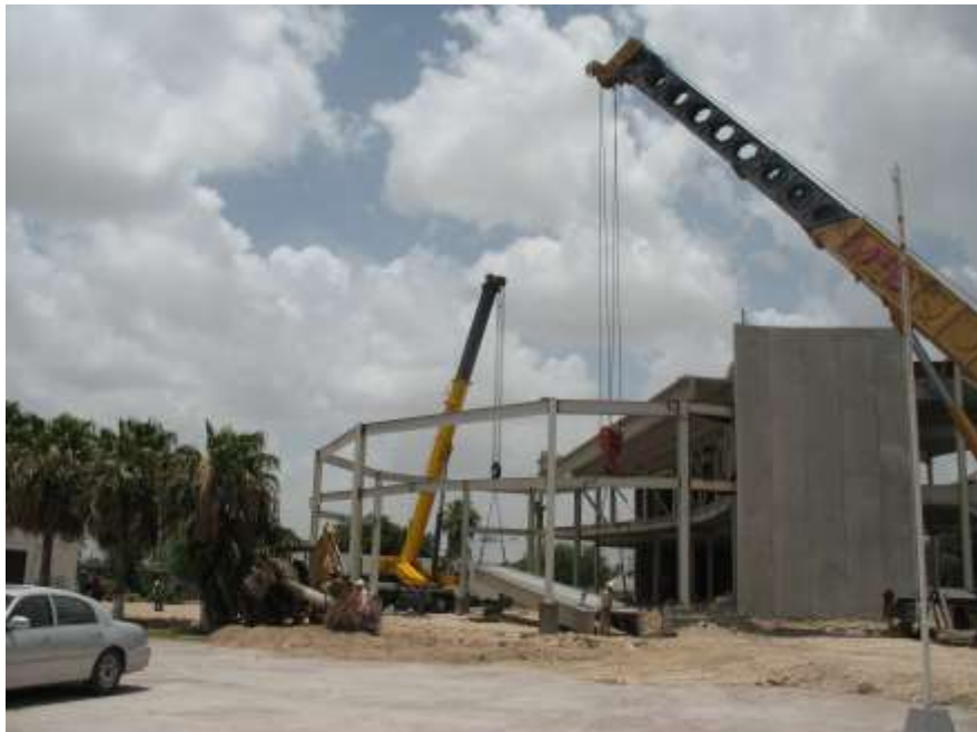
Etapa intermedia de construcción del Edificio Polifuncional, Junio de 2014
