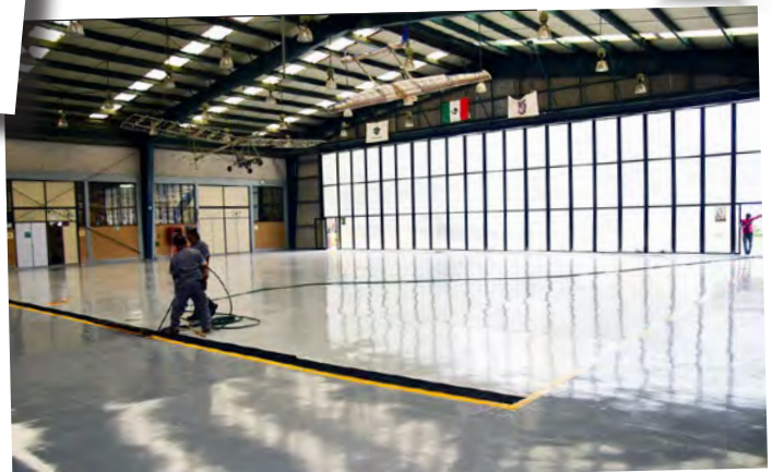
Mantenimiento al piso del hangar de la ESIME Ticomán
