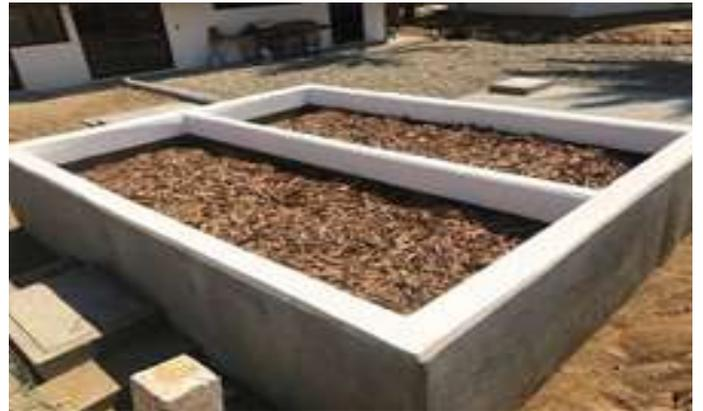
Sistema de tratamiento de agua residual a escala real construido en Centro Turístico en Puerto Escondido Oaxaca, con la tecnología biofiltro empacado con Prosopis
