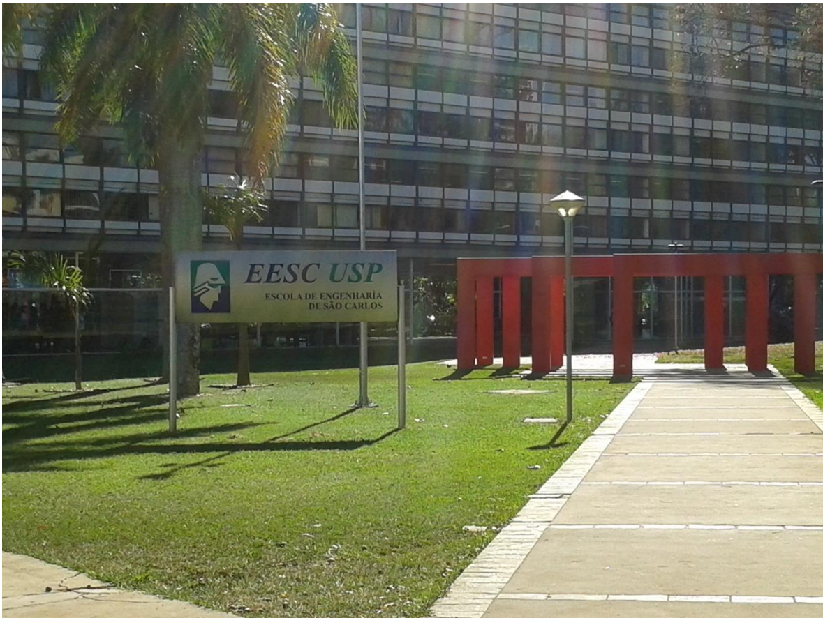
Edificio principal de la EESC-USP
