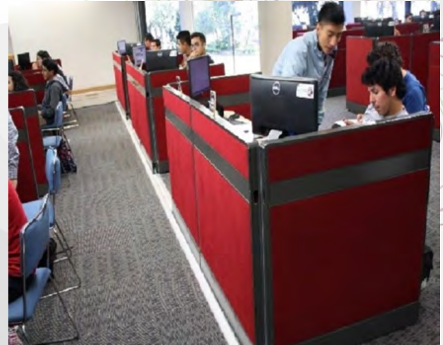
Desmontaje y montaje de canaletas por cambio de alfombra, Diciembre de 2015.
