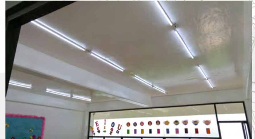
Cambio de Luminarias, Para el Ahorro de Energia.
