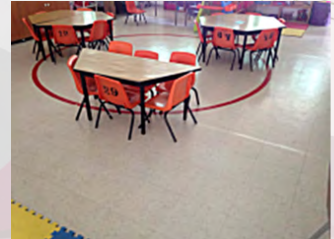
Cambio de Piso Vinilico.
