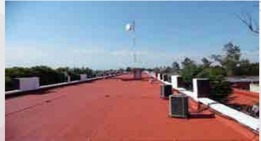
Impermeabilización.
