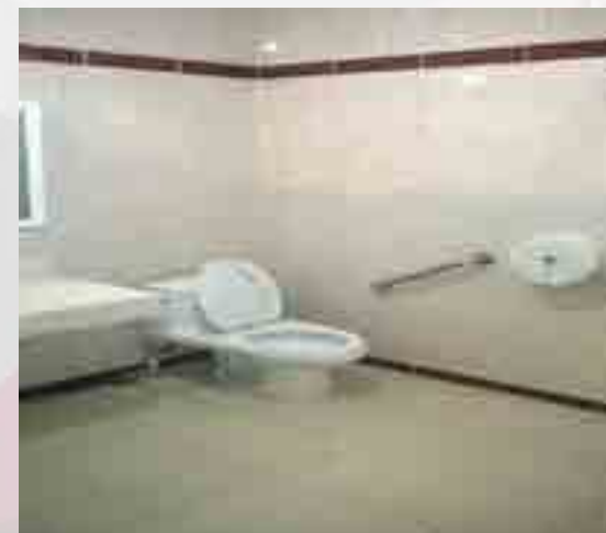
Habilitación de Sanitarios.
