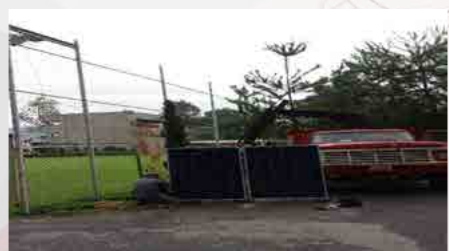
Panorámica de las luminarias solares en las instalaciones de la cancha de la ENMH.
