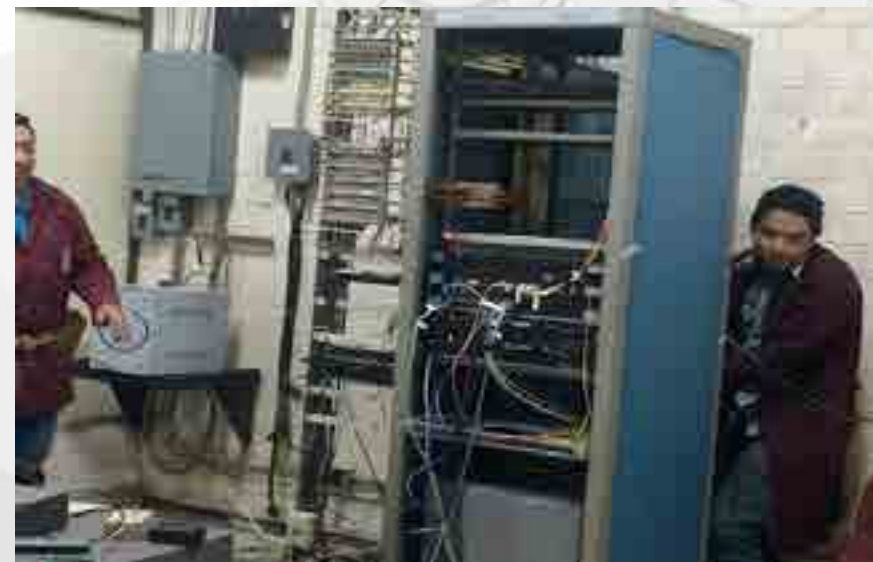
Limpieza de cableado.
