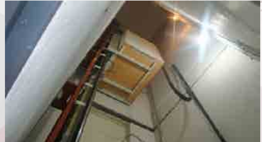
Mantenimiento al elevador.
