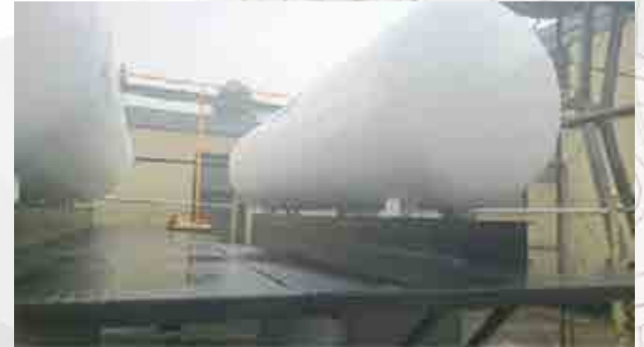
Cambio de instalación de gas.
