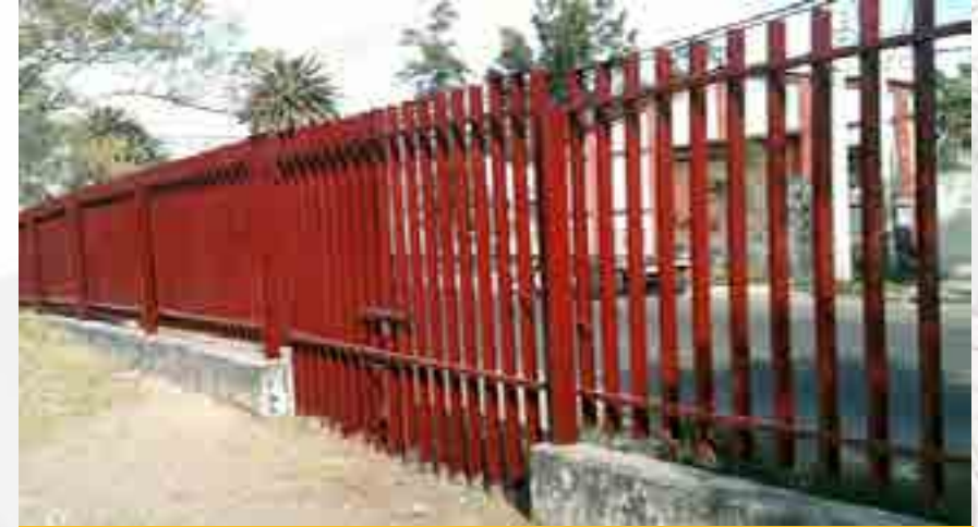
Reparación de reja.
