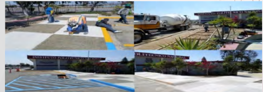
Remodelación de banqueta frontal
