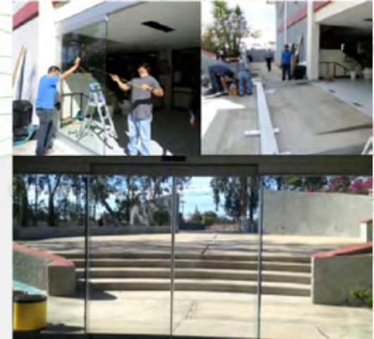
Instalación de puerta automática
