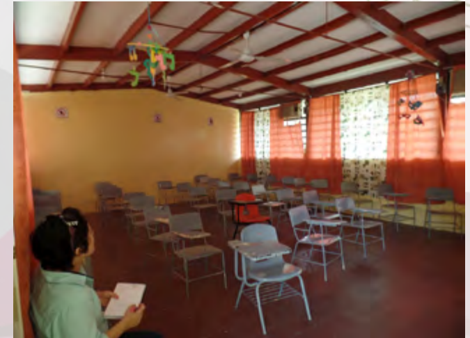
Levantamiento del censo de luminarias y equipo eléctrico en una de las escuelas.
