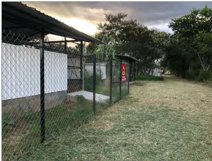
Sitio de Almacenamiento Temporal de Residuos Peligrosos
