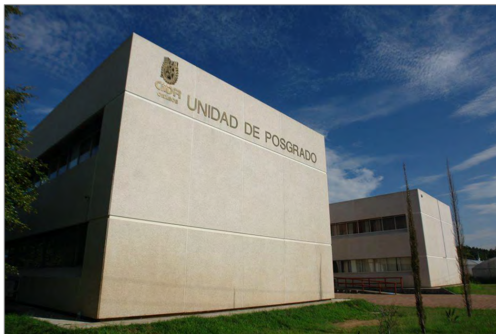
Edificio de la Unidad de Posgrado del CIIDIR Oaxaca
