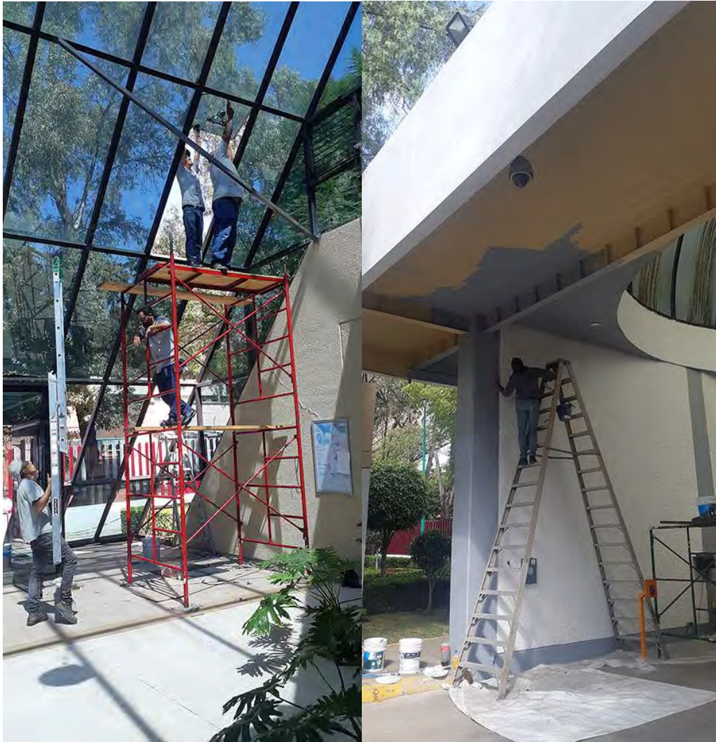
Actividades de mantenimiento realizadas en el CIITEC.
