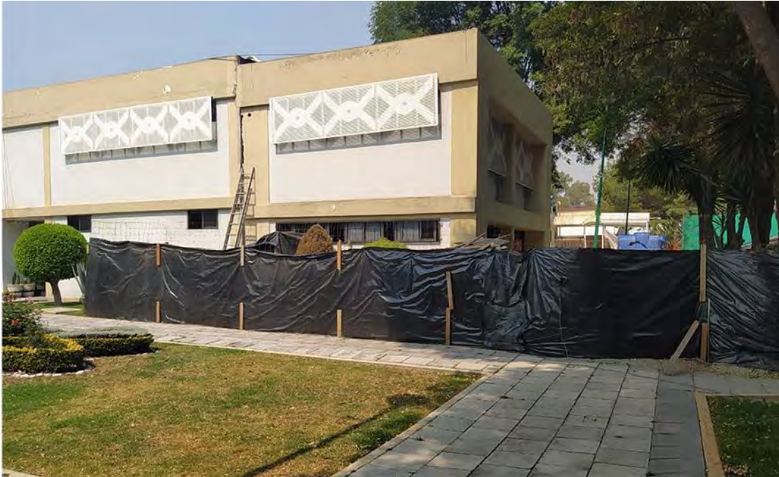
Trabajos de nivelación en anexo del edificio de posgrado.
