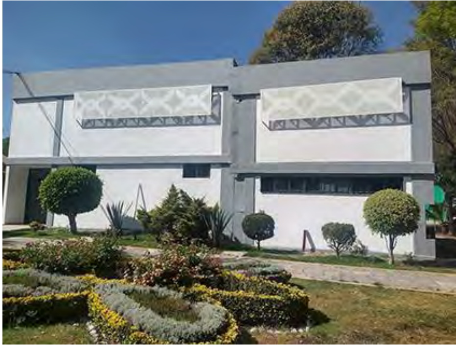
Anexo de edificio de Posgrado nivelado y rehabilitado.
