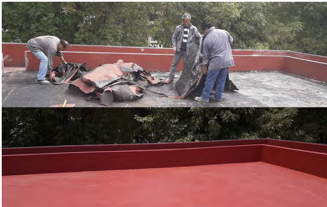
Mantenimiento a techo de edificio del CIITEC.
