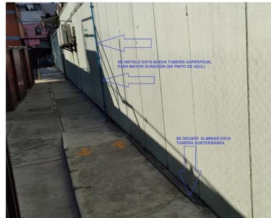
*Esquema de la tubería instalada.*
