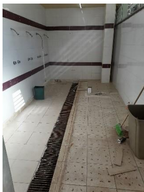
Trabajos de adaptación de área de regaderas.
