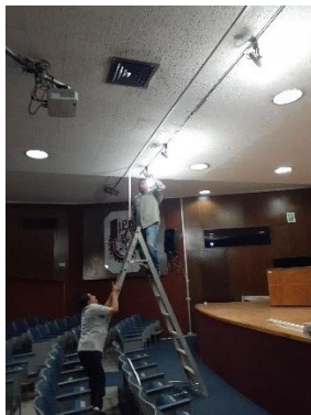
Colocación de soporte para cañón en aula del edificio A.
