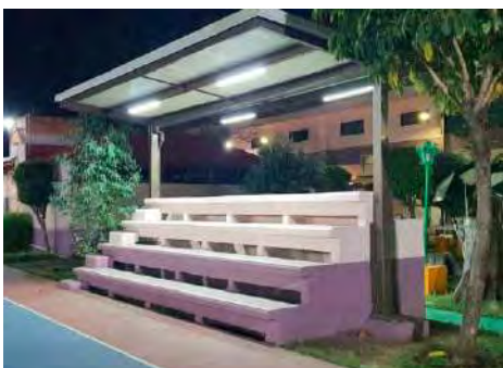
Techo de gradas
