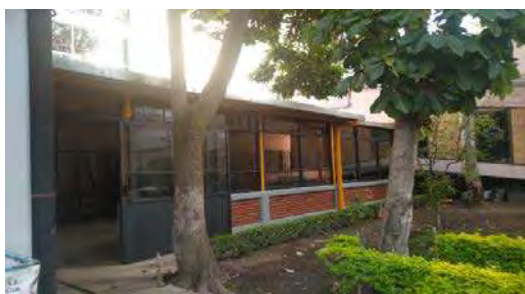
Techumbre taller de mantenimiento
