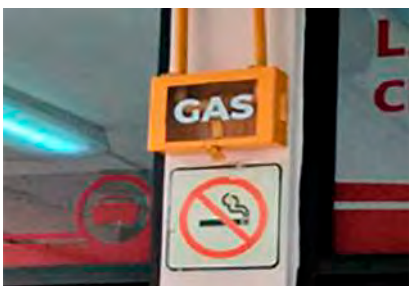
Línea de gas laboratorios segundo piso
