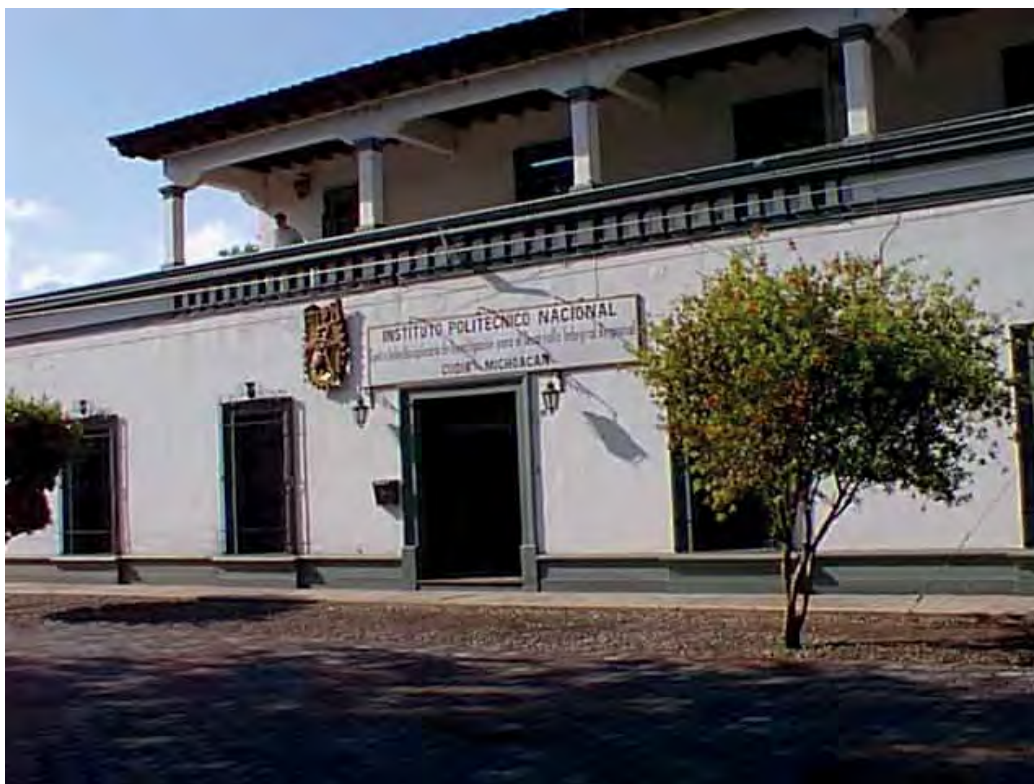
Fachada principal del CIIDIR
