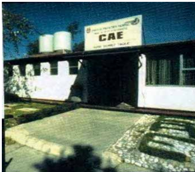
Fachada del Centro
