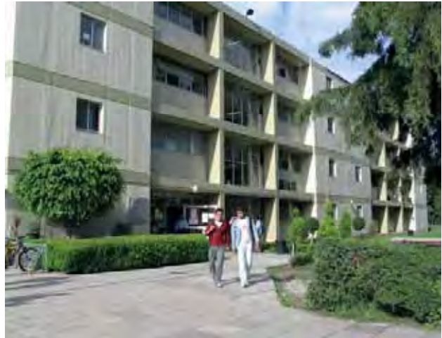
Fachada del Centro
