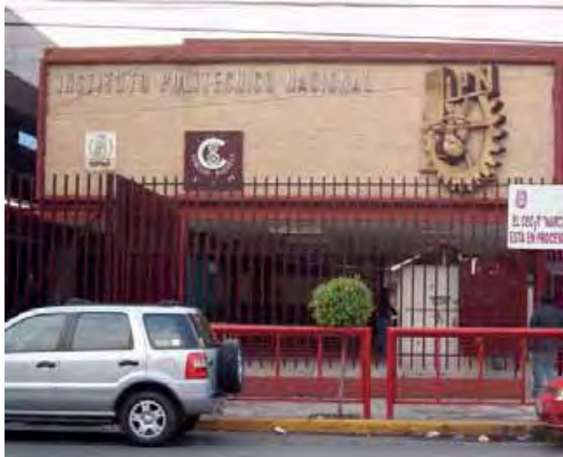
Fachada del centro
