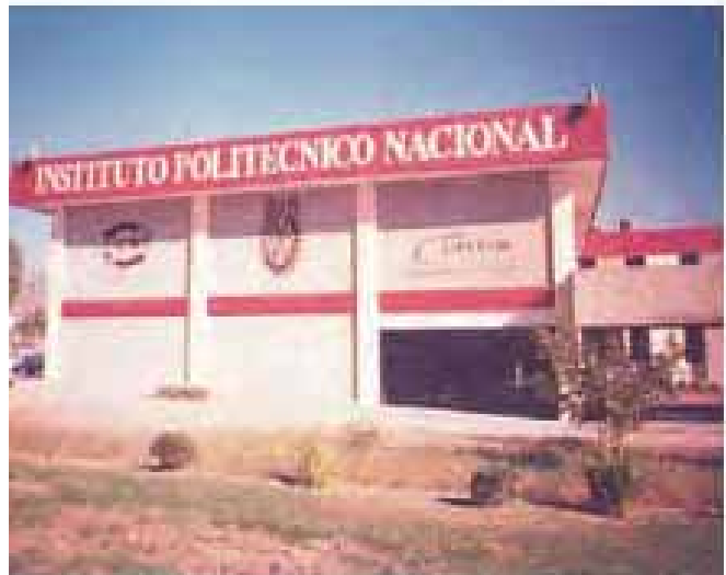
Fachada del Centro
