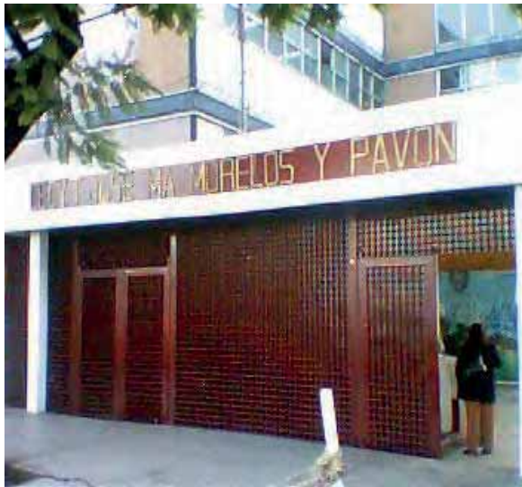
Fachada del Centro
