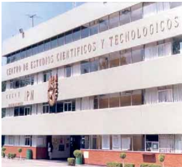
Edificio de Gobierno
