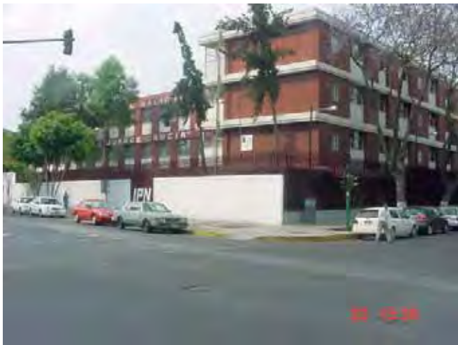
Fachada del Centro
