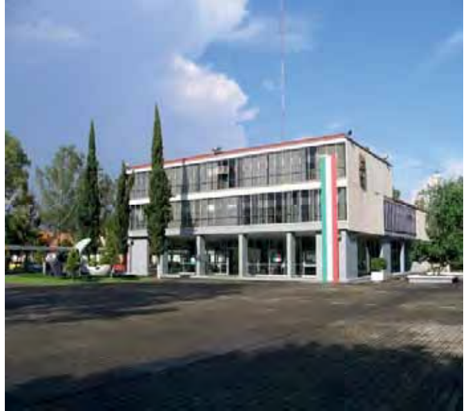
Vista interior de la Escuela
