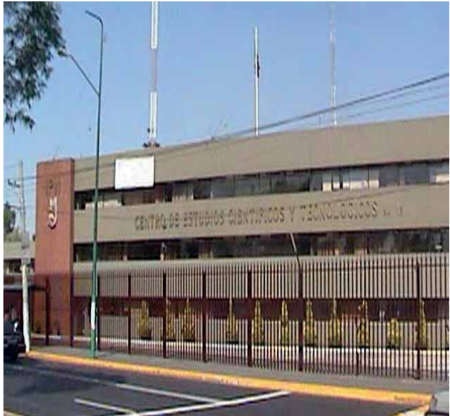
Fachada del Centro
