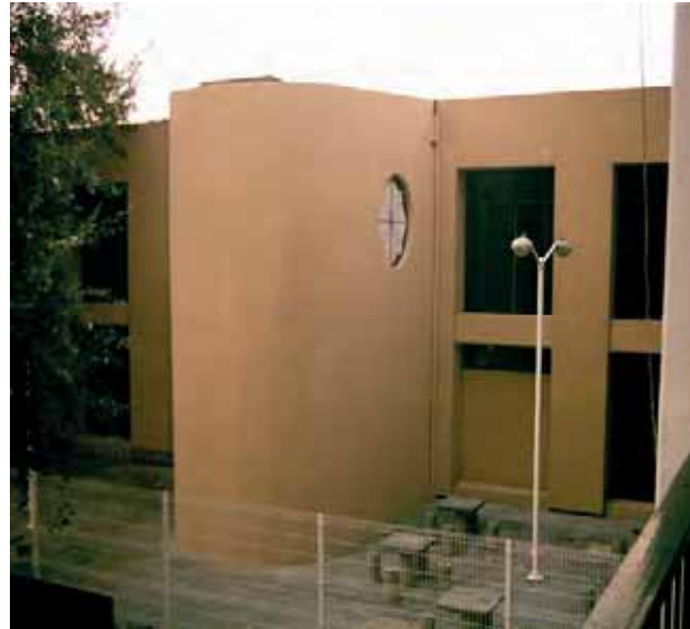
Vista interior del Centro
