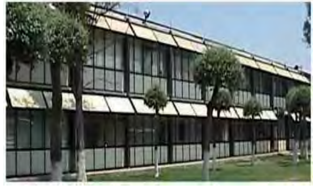
Fachada del Centro
