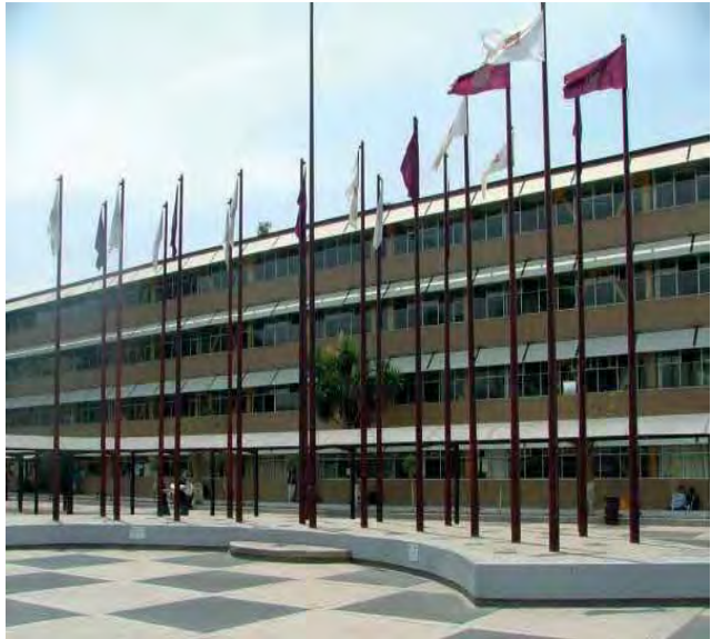
Vista del interior del Centro
