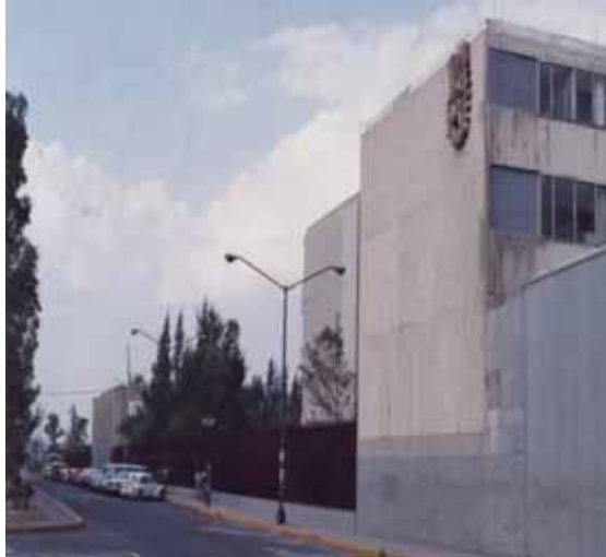
Fachada del Centro
