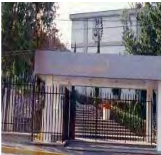
Fachada del Centro
