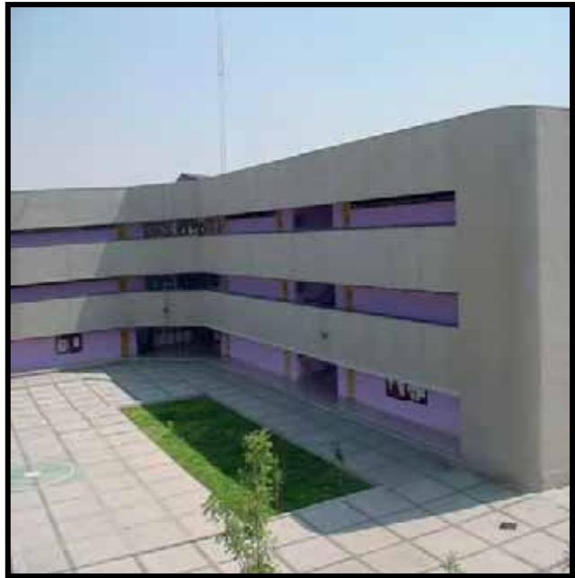
Vista interior del Centro
