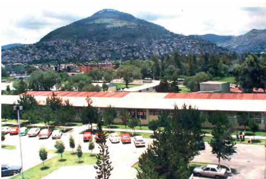
Panorámica de las instalaciones de la ESIA Unidad Ticomán
