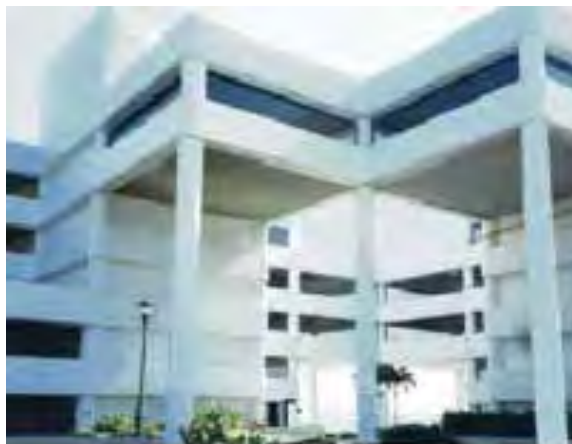
Fachada del centro
