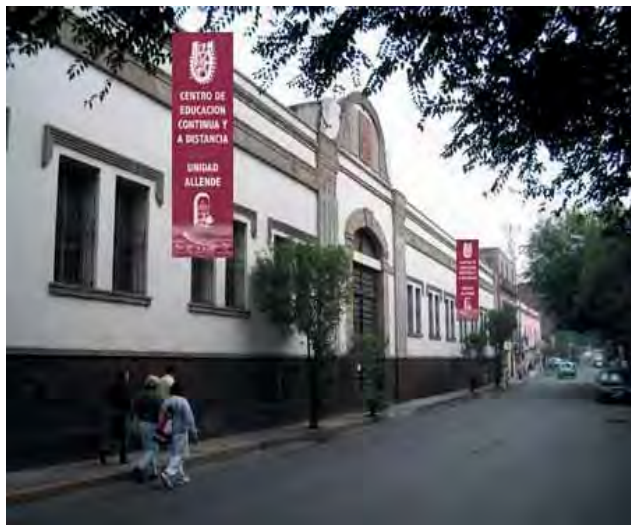
Fachada del centro
