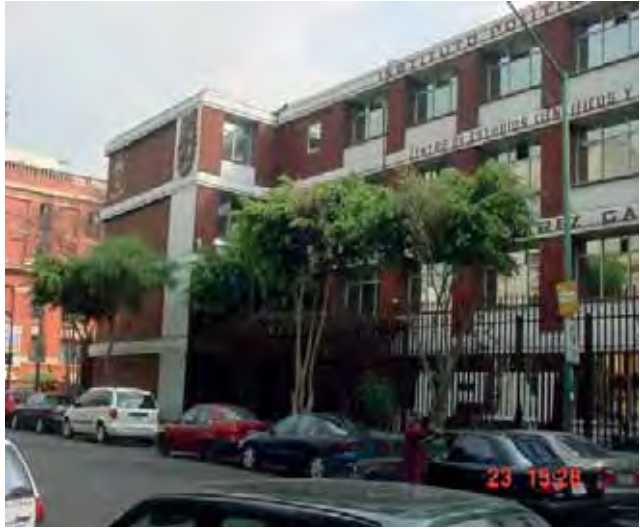
Fachada del Centro
