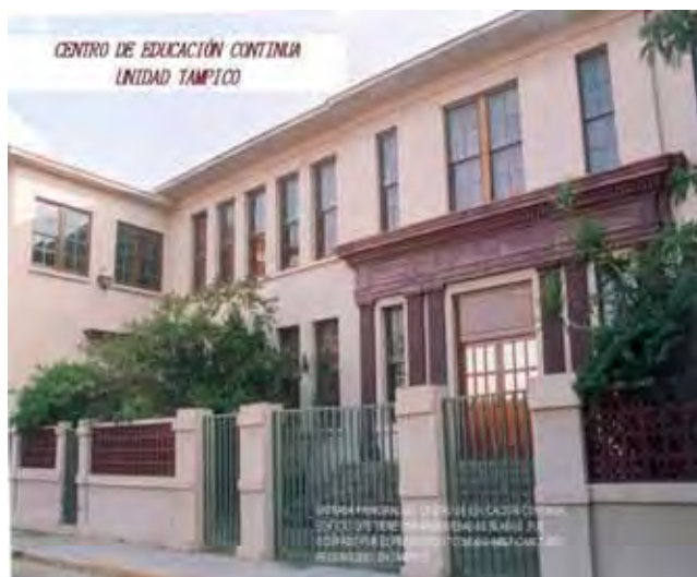
Fachada del Centro
