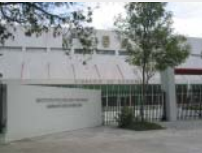
Remodelación de las instalaciones del Gimnasio de Exhibición
