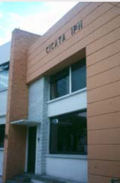
Instalaciones del CICATA, Unidad Legaria
