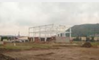
Construcción del nuevo edificio del CIEMAD
