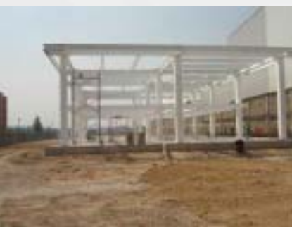
Construcción de las nuevas instalaciones del CMP+L
