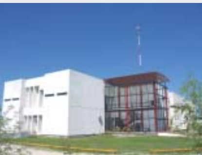
Instalaciones del CBG
