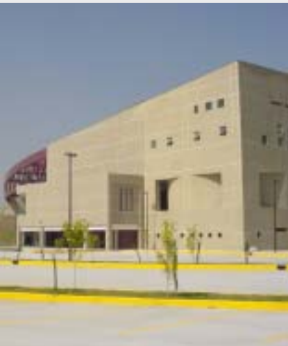
Instalaciones de la UPDCE
