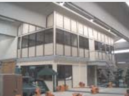
Construcción del mezzanine
