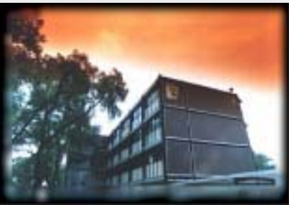
Instalaciones de XE-IPN Canal 11
