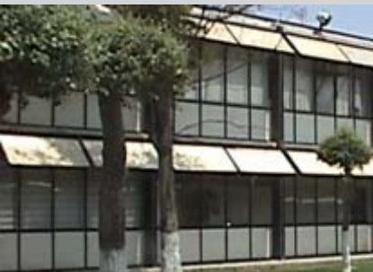
Instalaciones del CMP+L
