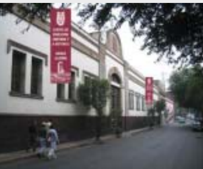
Instalaciones del CEC, Unidad Allende
