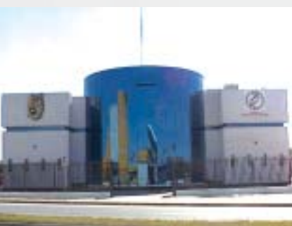
Instalaciones del CBG
