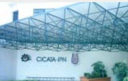
Instalaciones del CICATA, Unidad Legaria
