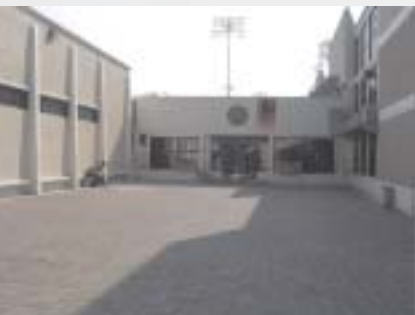
Instalaciones del CICS, Unidad Santo Tomás
