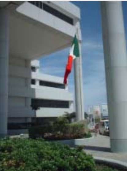
Instalaciones del CEC, Unidad Cancún
