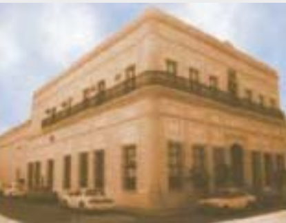
Instalaciones del CEC, Unidad Culiacán
