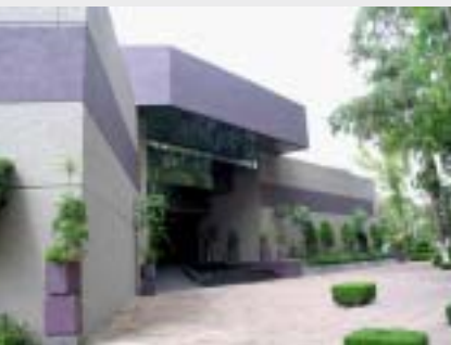
Instalaciones de la Dirección de Servicios Informáticos
