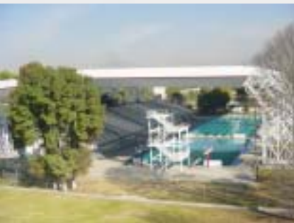
Remodelación de las instalaciones de la alberca
