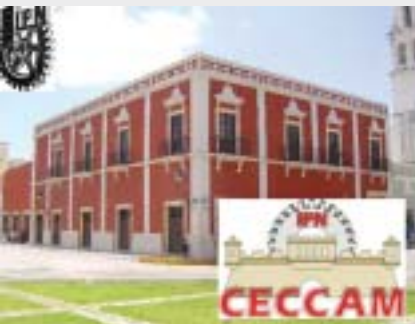
Instalaciones del CEC, Unidad Campeche
