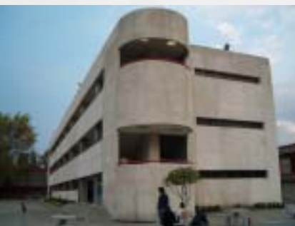
Instalaciones del Centro
