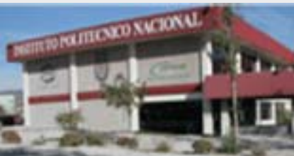
Instalaciones del CEC, Unidad Tijuana
