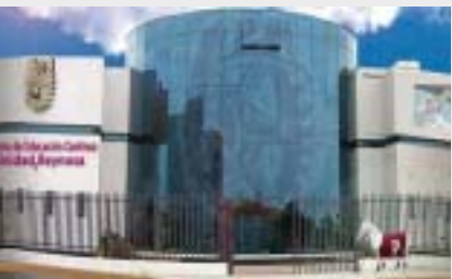
Instalaciones del CEC, Unidad Reynosa
