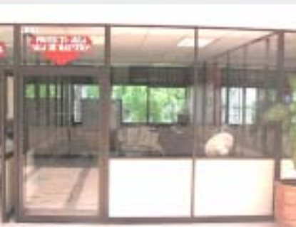
Instalaciones del Centro
