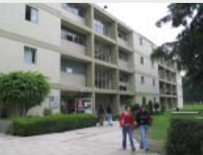
Instalaciones del CENLEX Unidad Zacatenco
