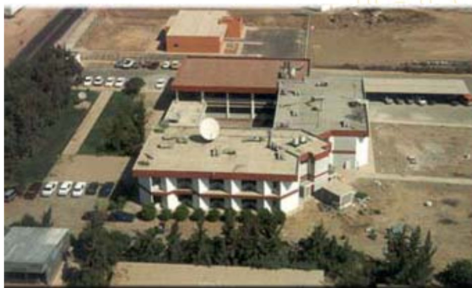
Panorámica de las Instalaciones del CITEDI
