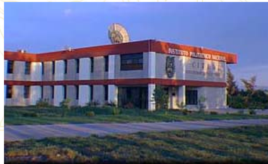
Instalaciones del CITEDI
