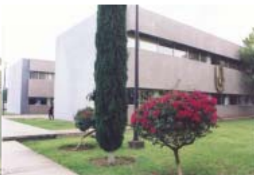
Instalaciones del CEC Oaxaca
