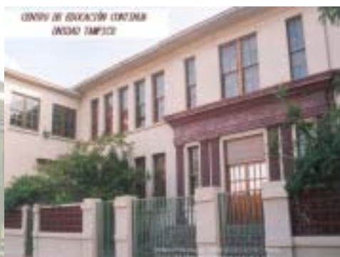
Instalaciones del CEC Tampico
