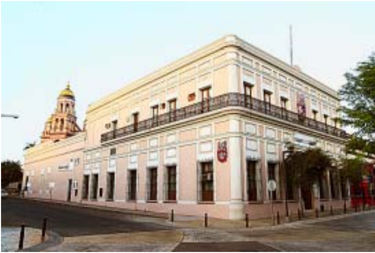
Instalaciones del CEC Unidad Culiacán
