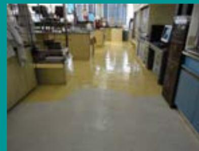
Instalación de pisos de pintura epóxica y mantenimiento general a los desfuegos y extractores de las campanas del Laboratorio de Química.
