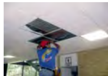
Cambio de Instalación Eléctrica para ahorro de Energía
