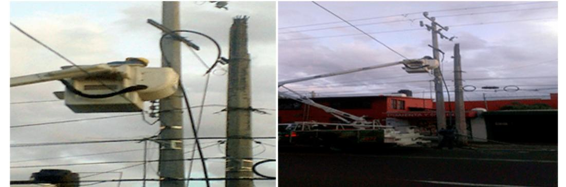
Personal de CFE con grúa instalando los cables de alimentación.
