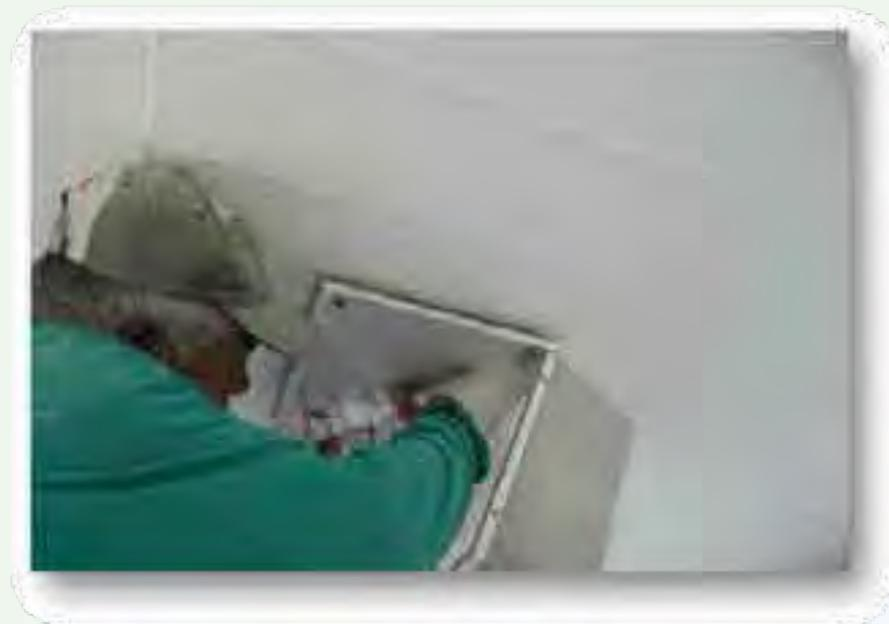
Cambio de luminarias de 175 watts a 65 watts, en los pasillos de la Dirección General, cumpliendo con la Ley de Energía y la Comisión Nacional para el Uso Eficiente de la Energía (CONUE).
