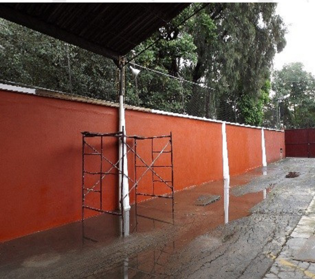
Reconstrucción de barda perimetral.
