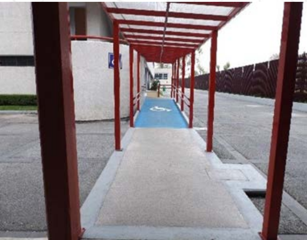
Construcción de rampas de acceso para discapacitados.
