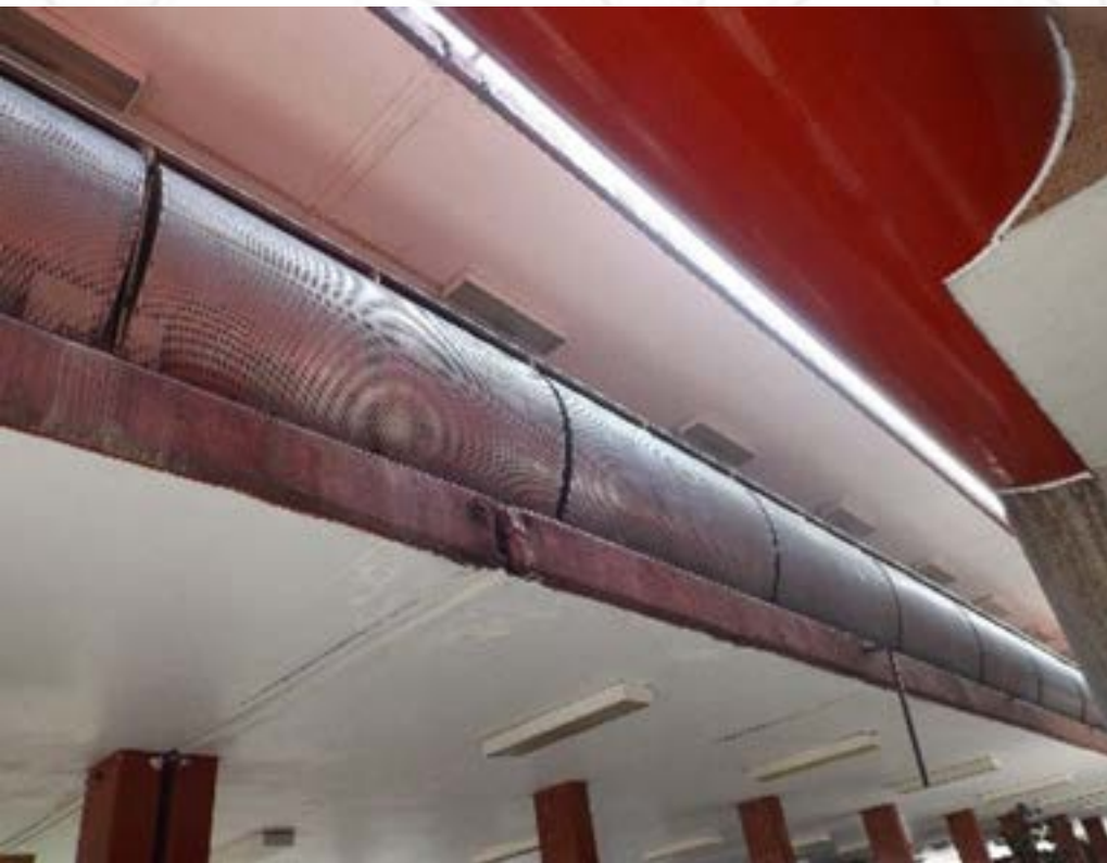
Instalación de nuevos barandales de lámina perforada.
