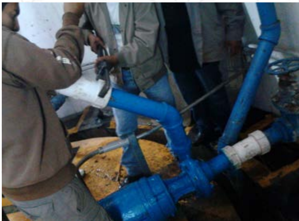
Mantenimiento a red de agua potable.
