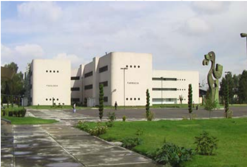
Instalaciones de la ENCB en Zacatenco.
