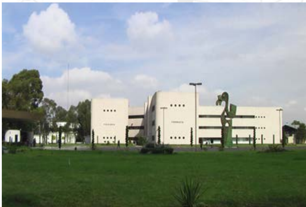
Instalaciones de la ENCB en Zacatenco.
