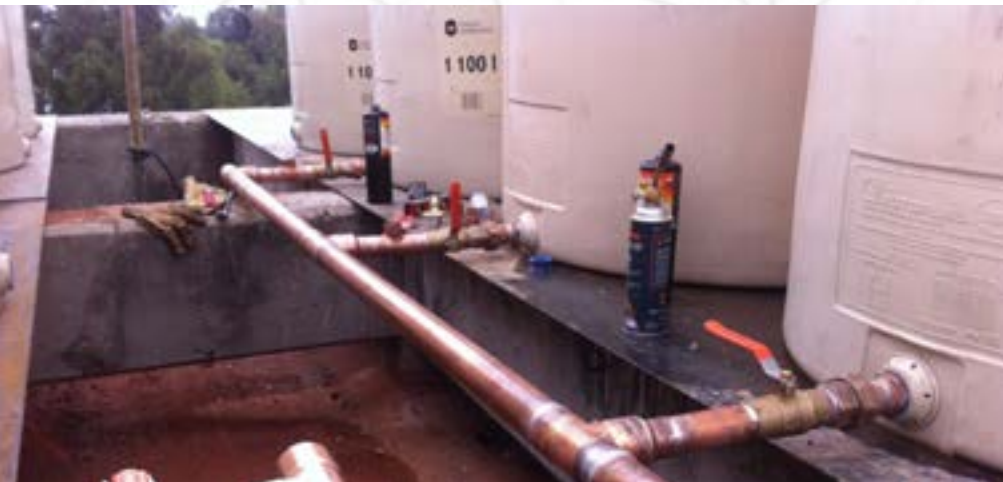
Mantenimiento a tinacos edificio principal Casco de Santo Tomás.
