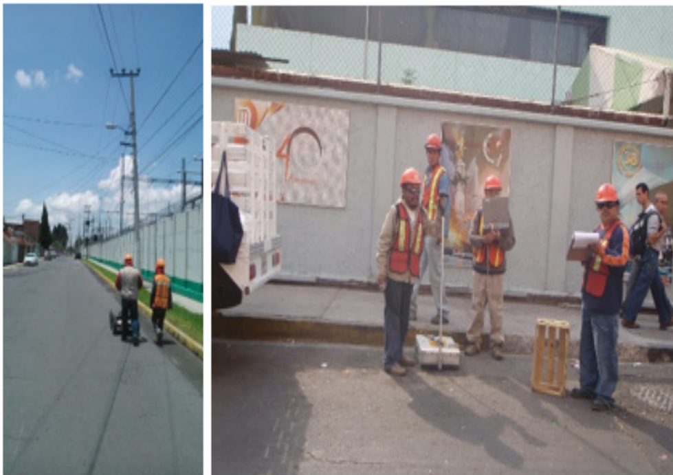
Estudio de Georradar "Línea de Transmisión Culhuacán-Xochimilco".
