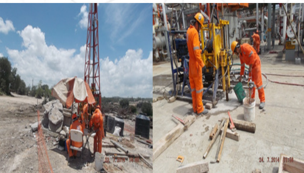
Trabajos en Geotecnia en la "Refinería Miguel Hidalgo".
