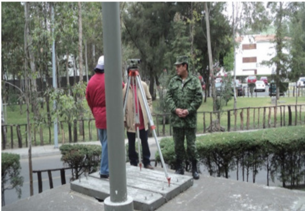
Estudio de Topografía en la Subestación Chimalpa.
