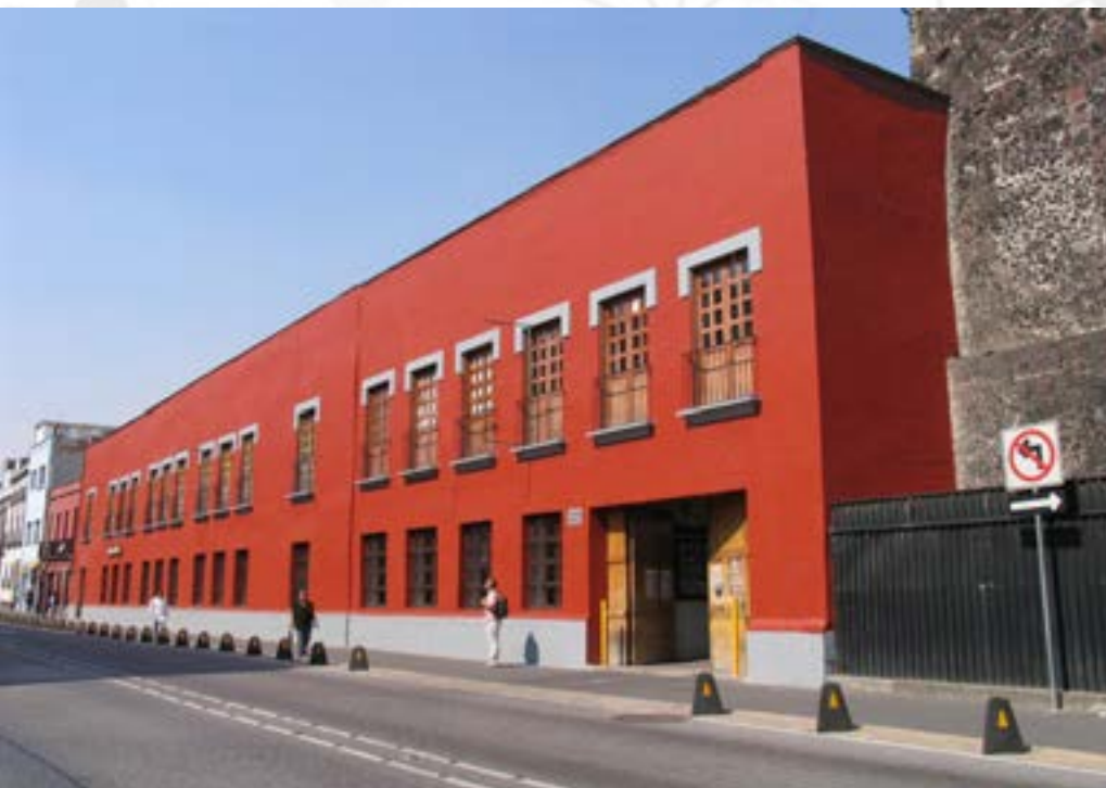
Fachada del CEC Allende.
