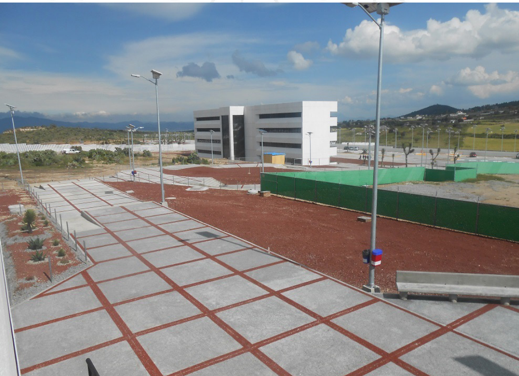
Edificio de Aulas.
