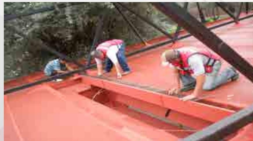
Servicio de desazolve, impermeabilización y cambio de rejillas en bajadas pluviales.
