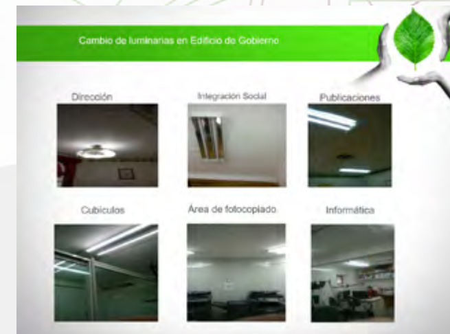
Cambio de luminarias en Edificio de Gobierno
