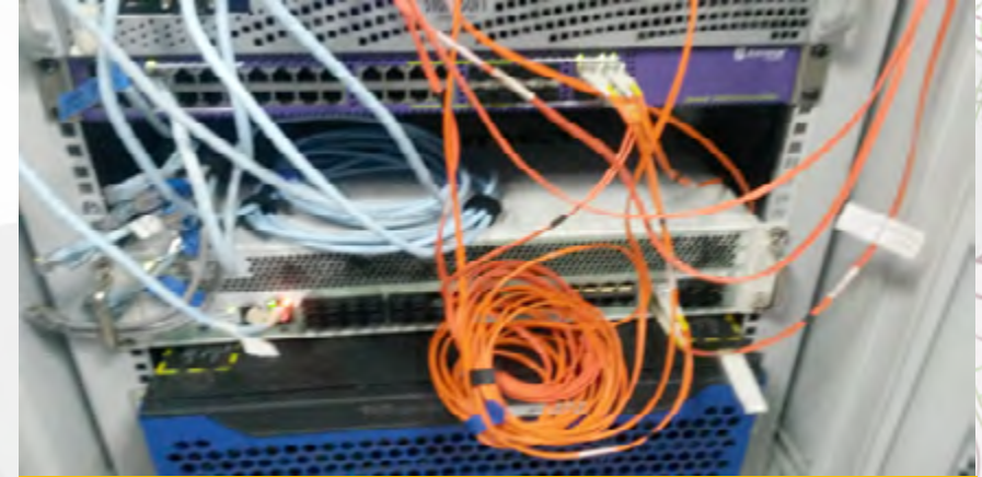
Instalación de sondas
