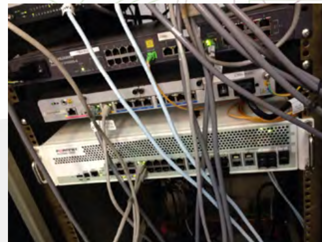
Instalación cableado estructurado
