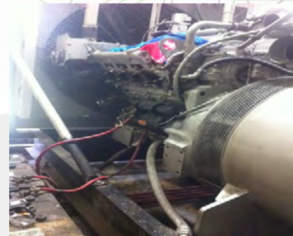
Mantenimiento a las plantas de emergencia
