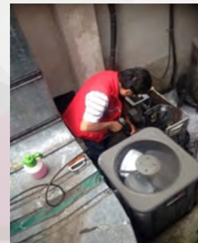
Mantenimiento aire acondicionado
