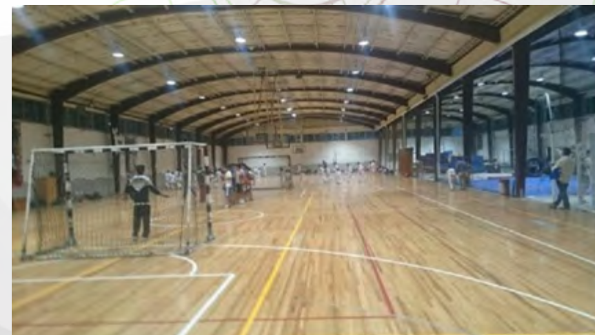
Rehabilitación del sistema de iluminación del Gimnasio Central Zacatenco de la Unidad Profesional “Adolfo López Mateos”.
