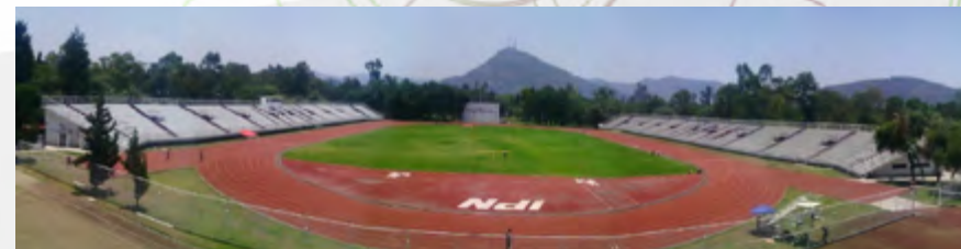
Rehabilitación del campo, gradas y sanitarios del Estadio “Wilfrido Massieu”.
