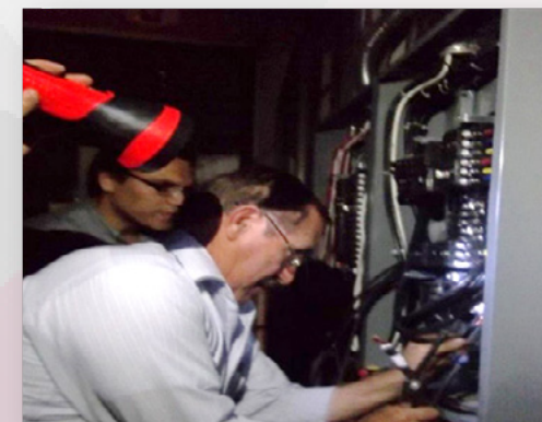
Reparación del centro de carga del edificio Adolfo Ruiz Cortines.
