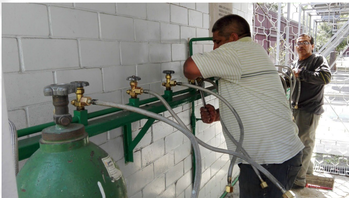
Mantenimiento a las tuberías de gas del Taller de Procesos Industriales
