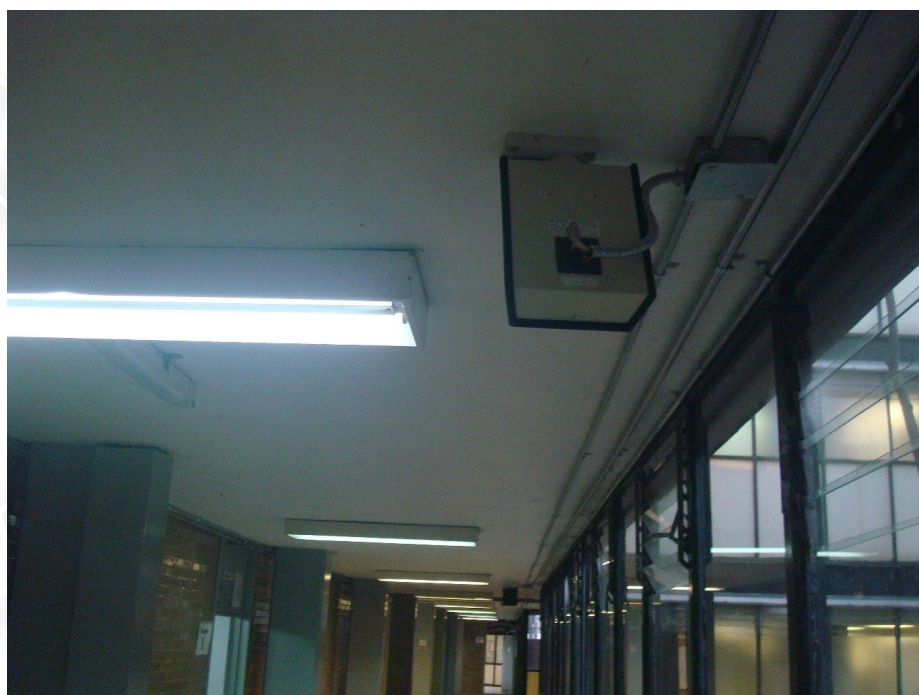
Implementación del sistema de voceo en cada uno de los edificios del inmueble
