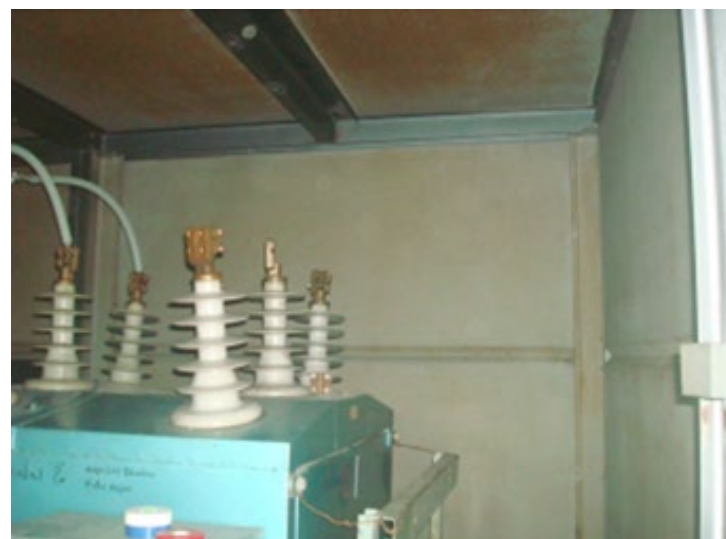
Mantenimiento correctivo a la subestación del CECyT 2
