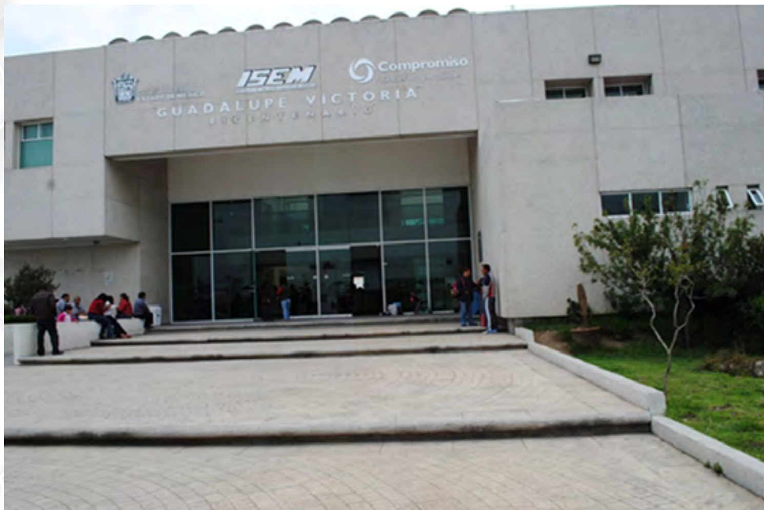
Hospital General de Texcoco, una de las nueve sedes hospitalarias nuevas
