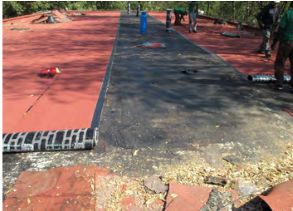
Colocación de impermeabilizante
