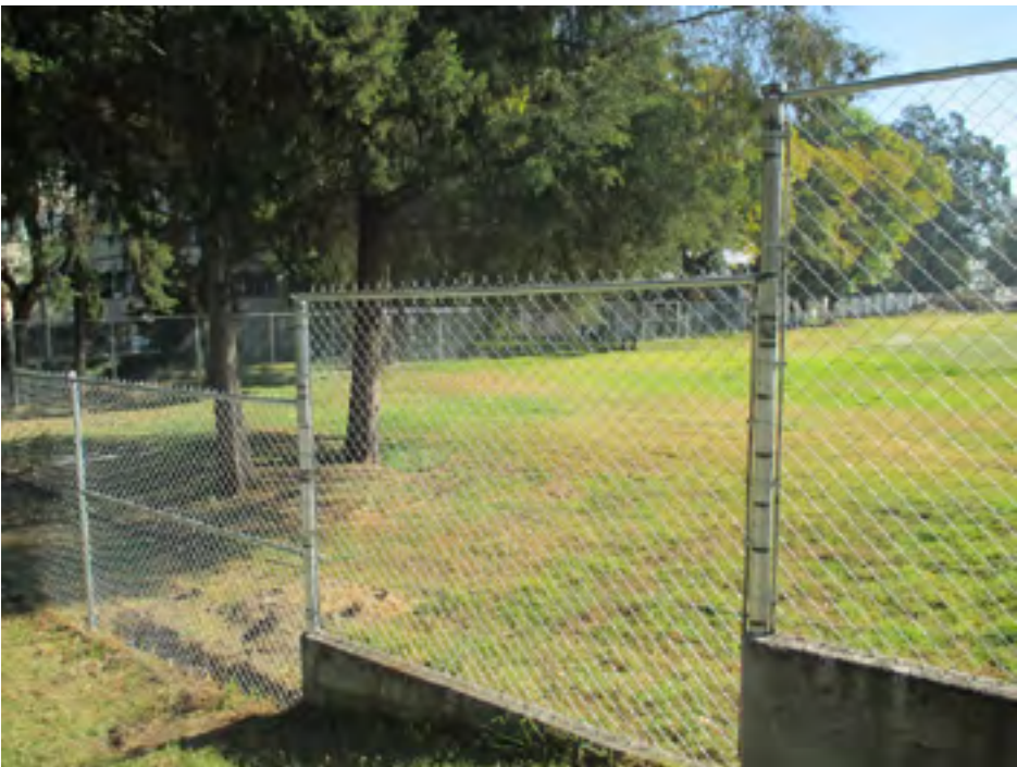
Colocación de malla
