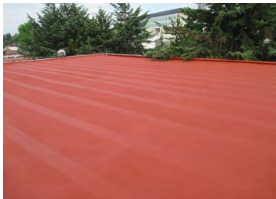
Colocación de impermeabilizante. Trabajo terminado
