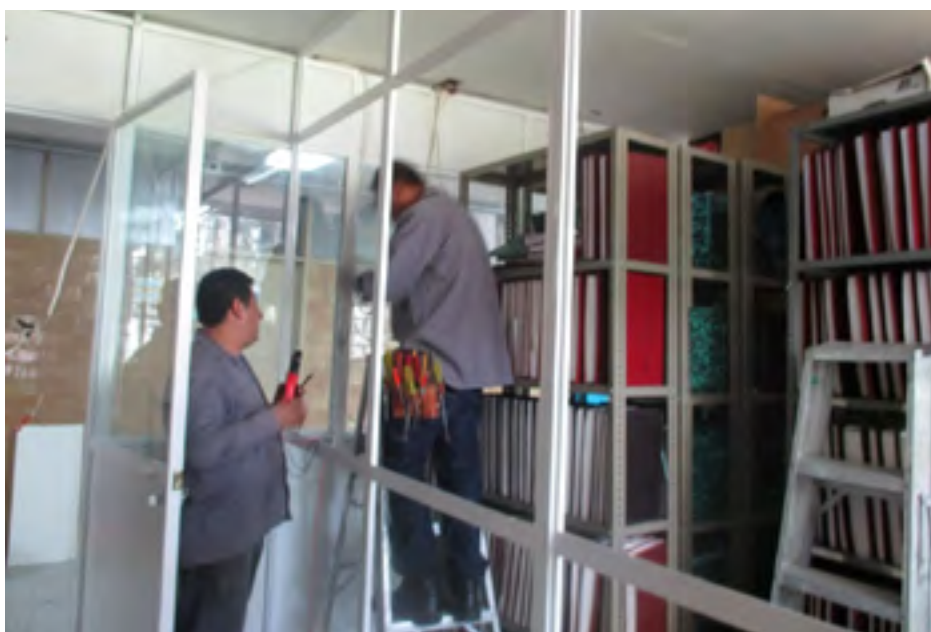
Colocación de cancelería
