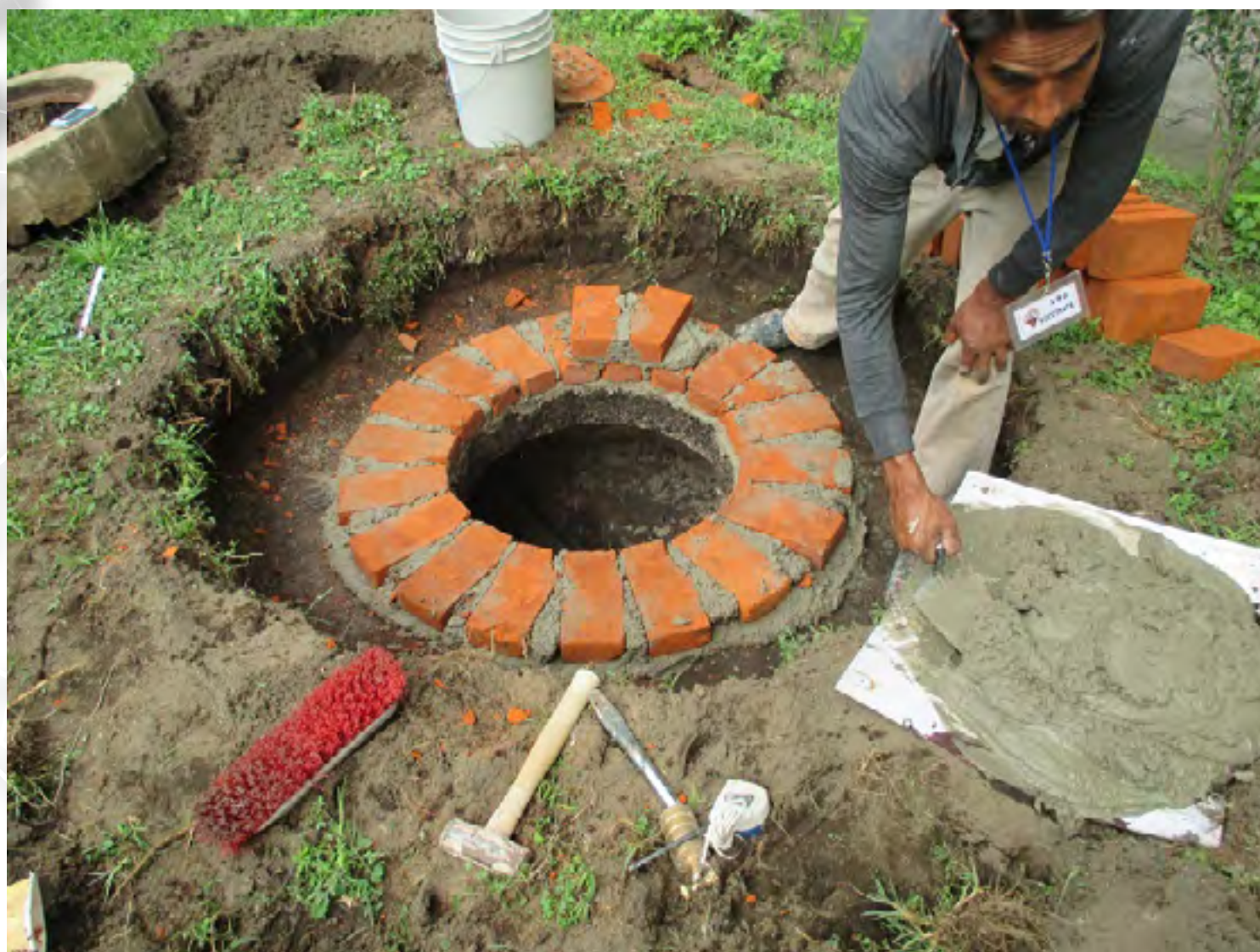
Renivelación de pozo hundido
