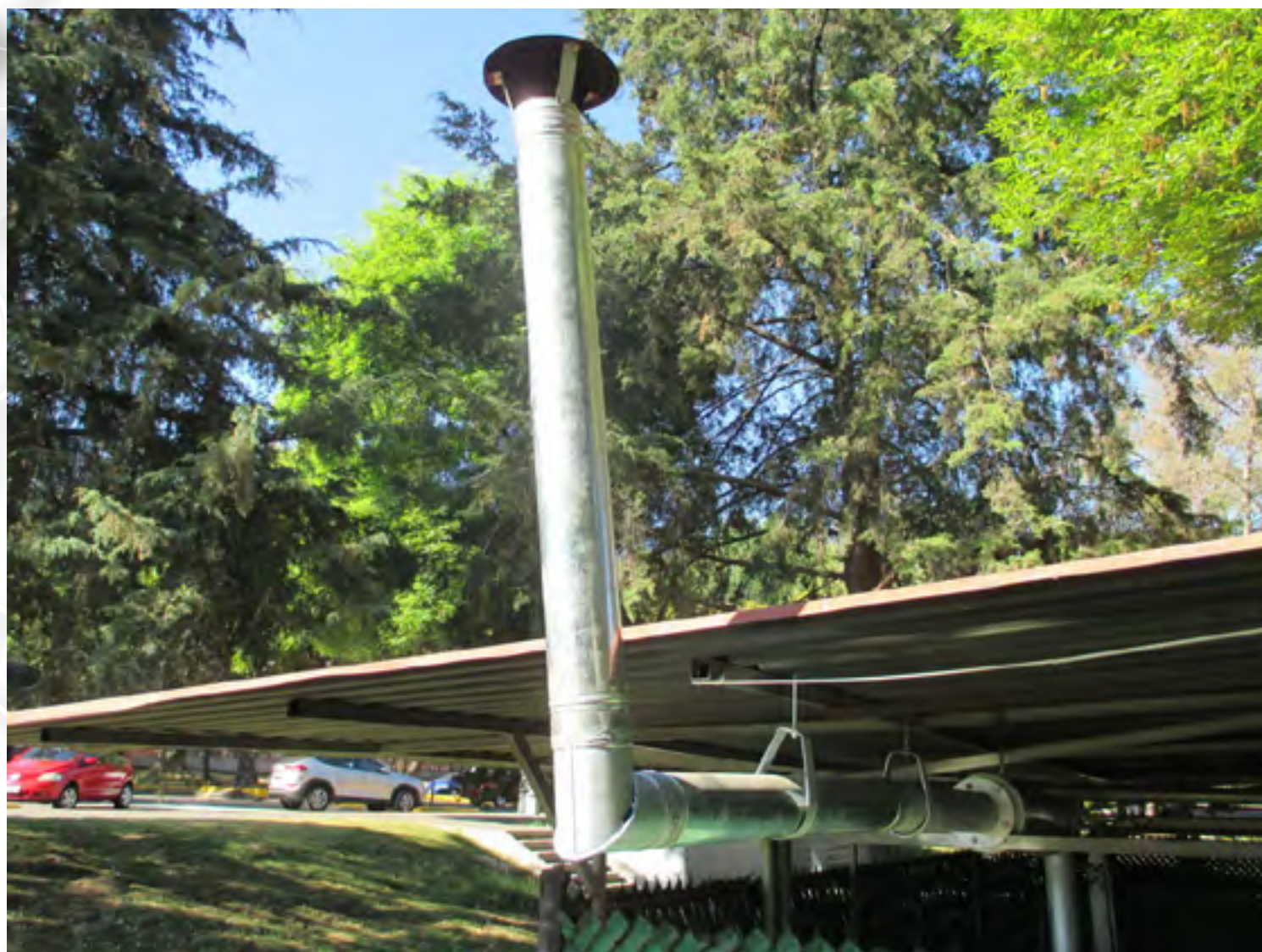
Reparación de tubería
