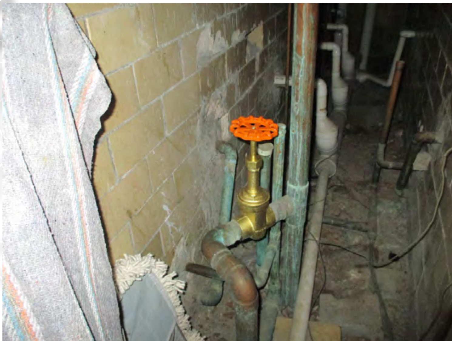
Colocación de válvula nueva
