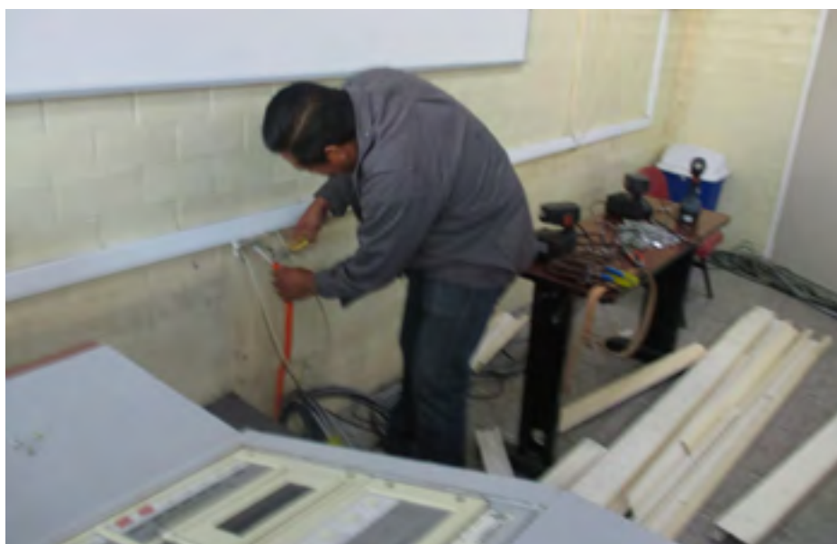
Mantenimiento a contactos
