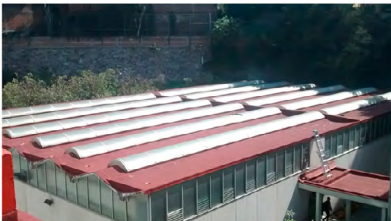
Instalación de impermeabilizante
