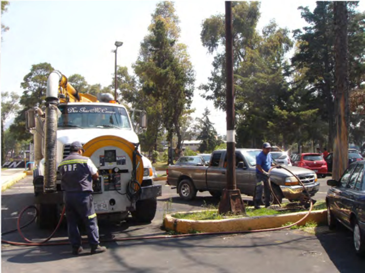
Desazolve del sistema de drenaje pluvial
