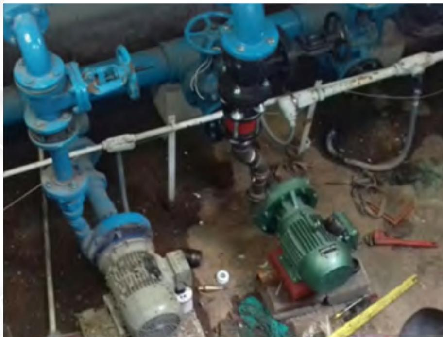
Imagen del mantenimiento en sistema hidroneumático
