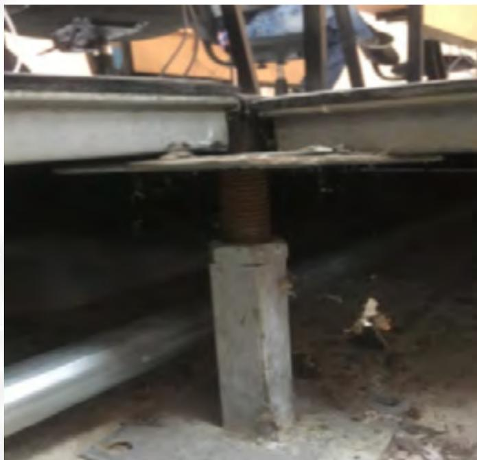
Nivelación, ajuste y cambios de pedestales de acero
