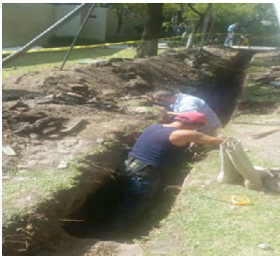
Excavación y cambio de tubería colapsada
