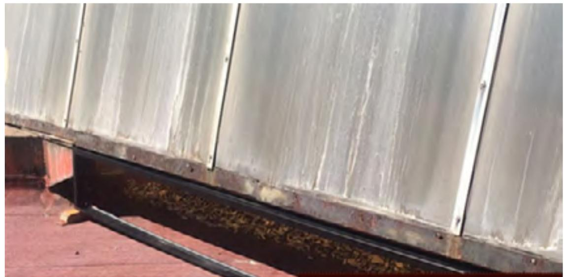
Estructura de herrería colocada entre piso y domo para sellado del espacio
