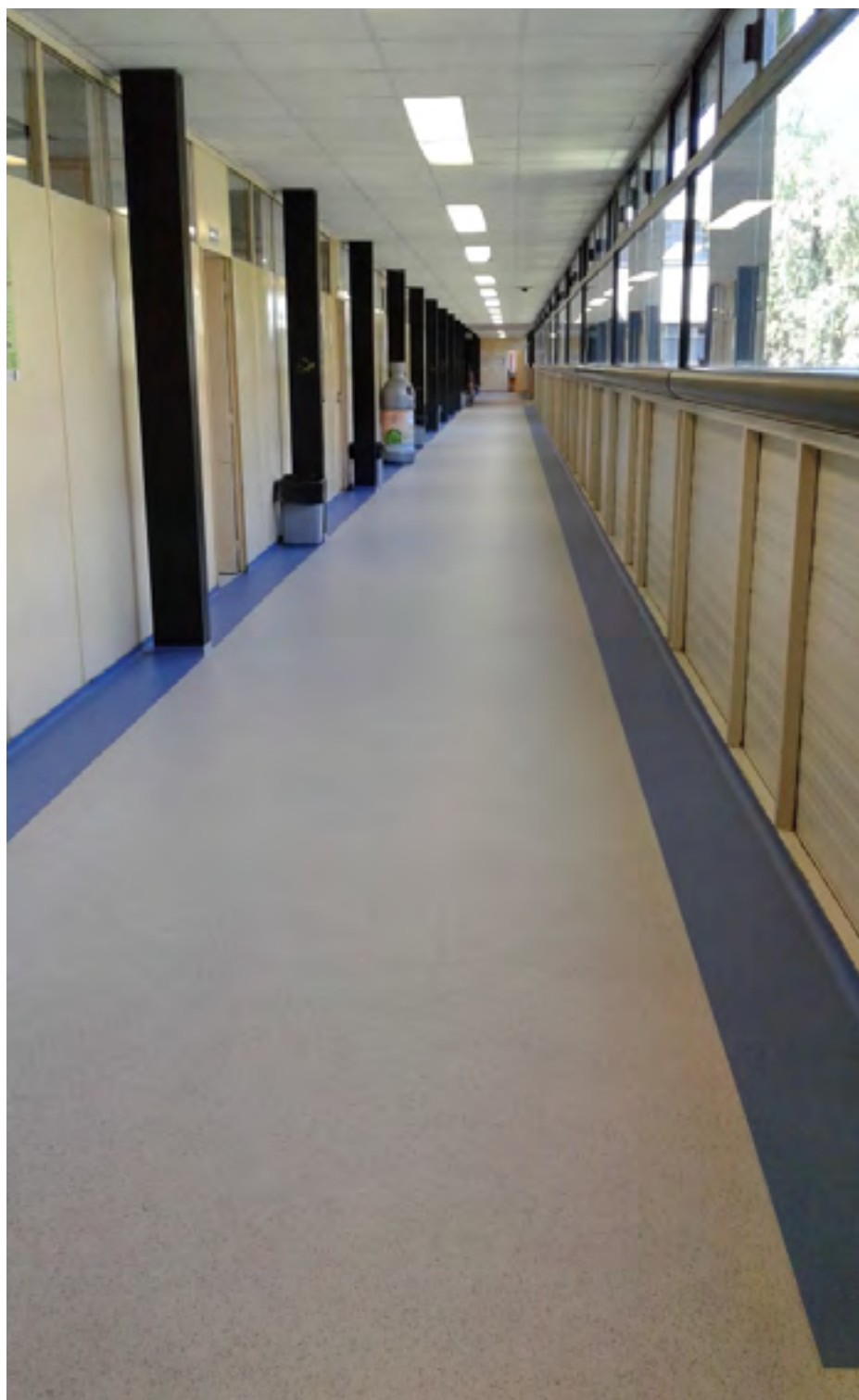
Remodelación de pasillos del edificio ocho
