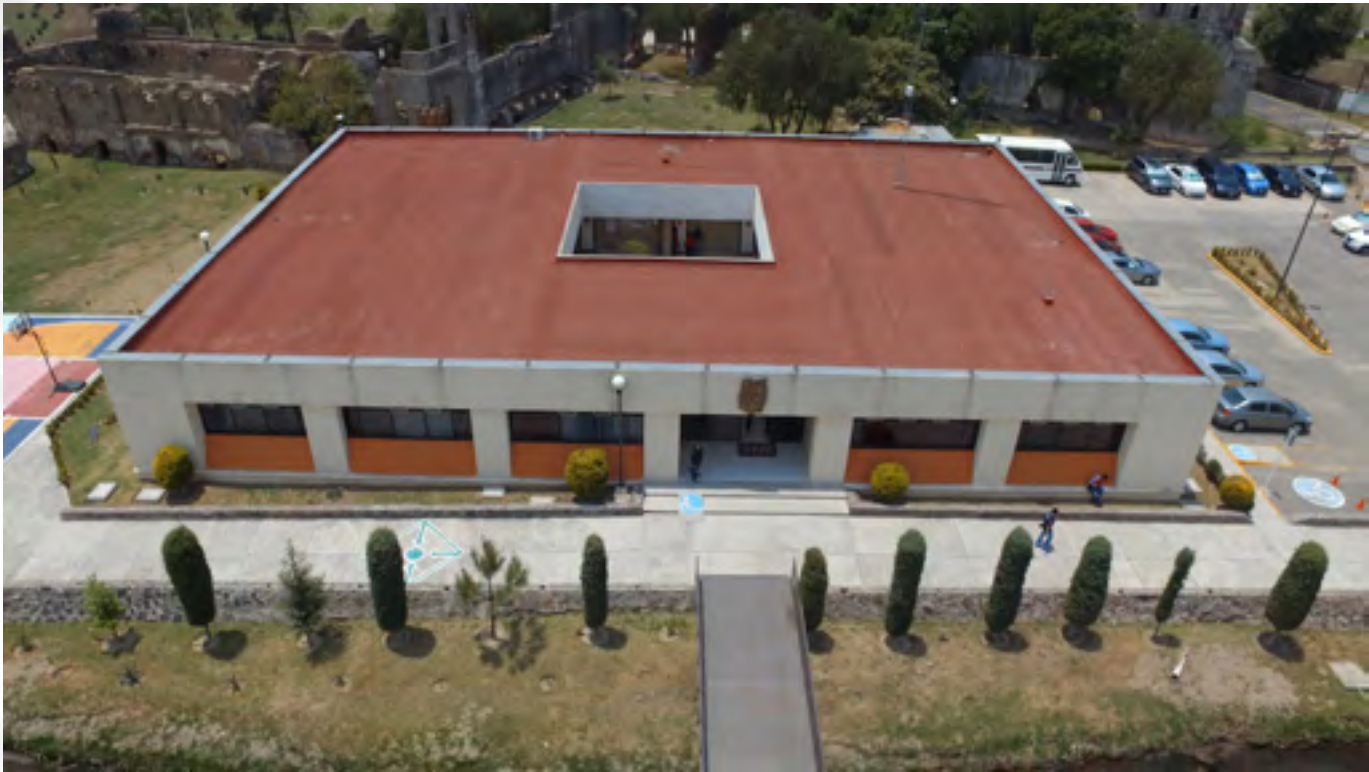
Instalaciones CIBA IPN
