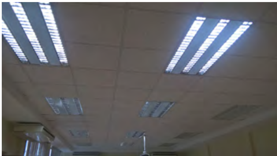
Instalación de luminarias en el salón de usos múltiples del CECUT
