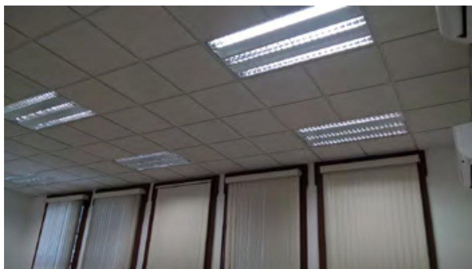
Instalación de luminarias en oficina administrativa del CECUT
