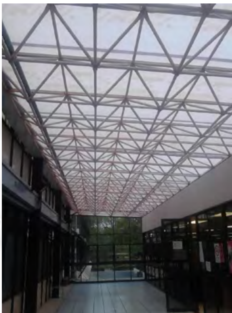
Cambio de cubierta de policarbonato
