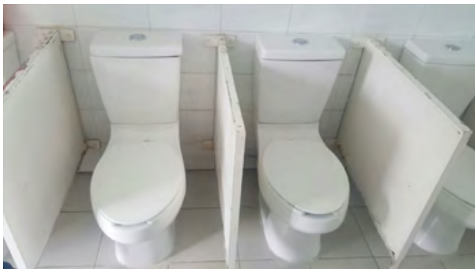
Sustitución de muebles sanitarios
