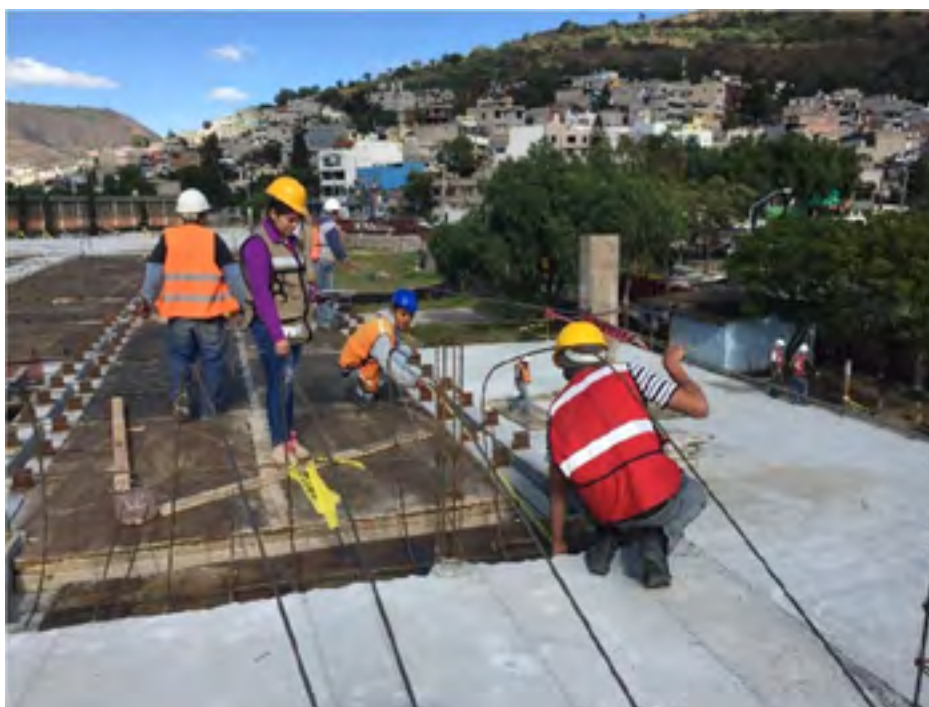
Supervisión del armado de losa
