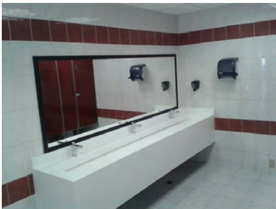
Sustitución de cubiertas, muebles y accesorios sanitarios
