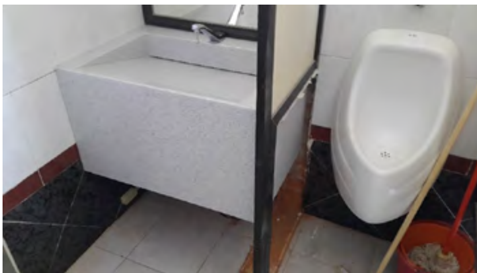
Sustitución de cubiertas y accesorios en sanitarios
