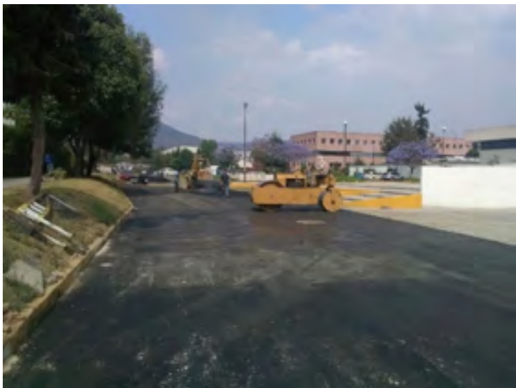
Trabajos de asfalto y bacheo
