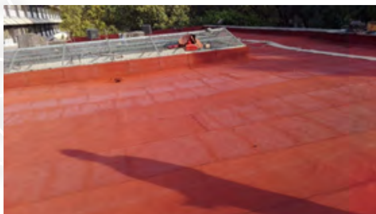
Trabajo de impermeabilización
