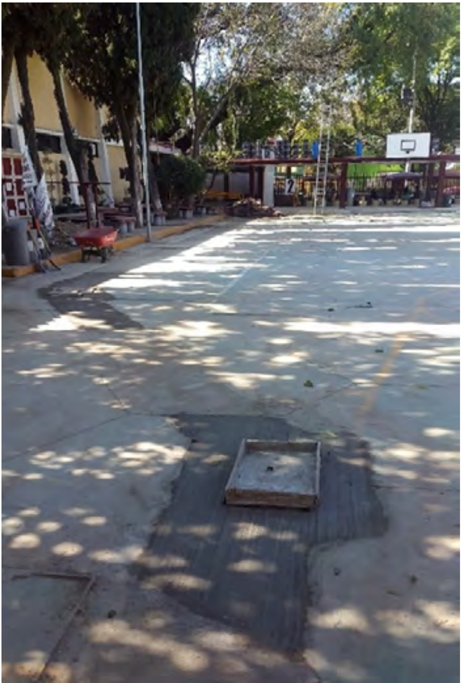
Sustitución de tubería y adición de registros
