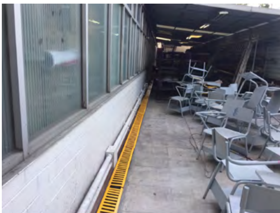
Limpieza de rejillas
