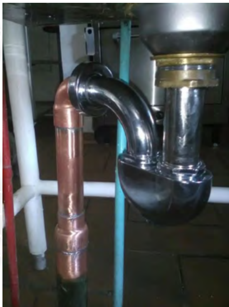
Sustitución de cespel
