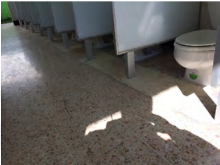
Sustitución de accesorios y muebles sanitarios
