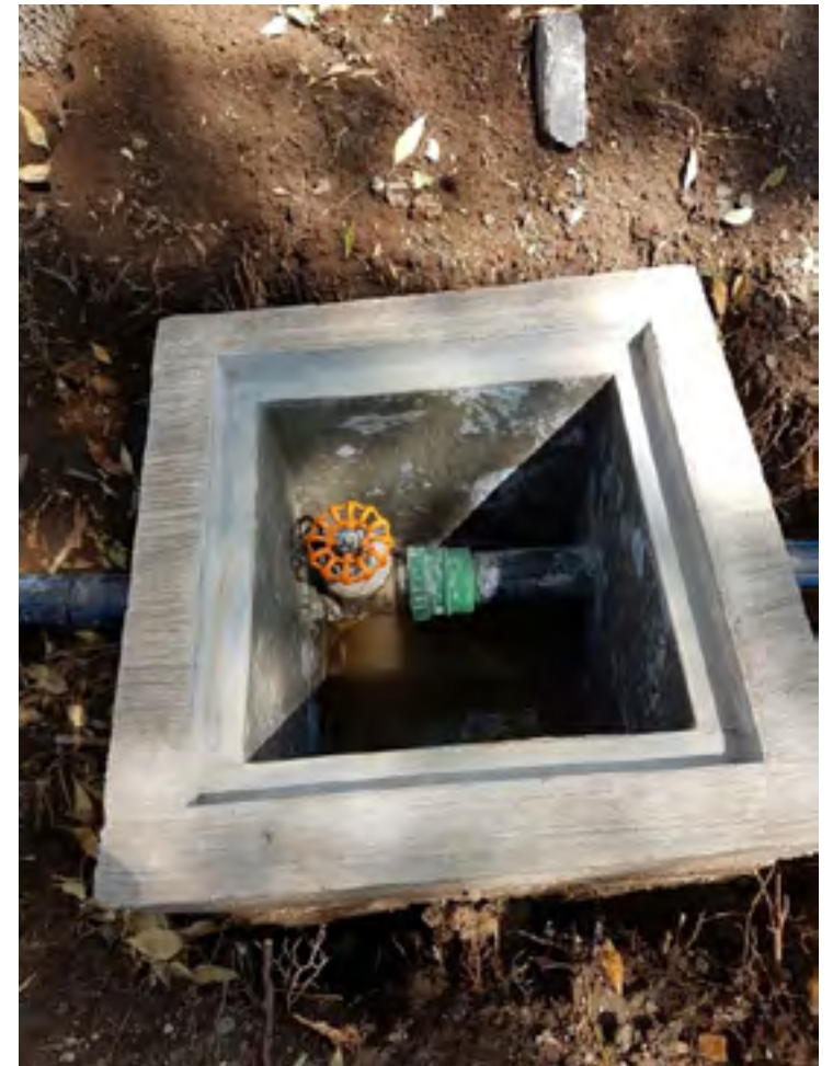
Trabajos complementarios, registro de válvula
