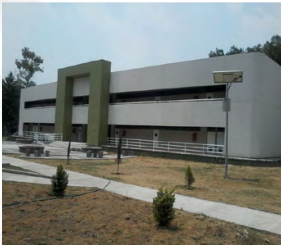
Vista superior obra exterior
