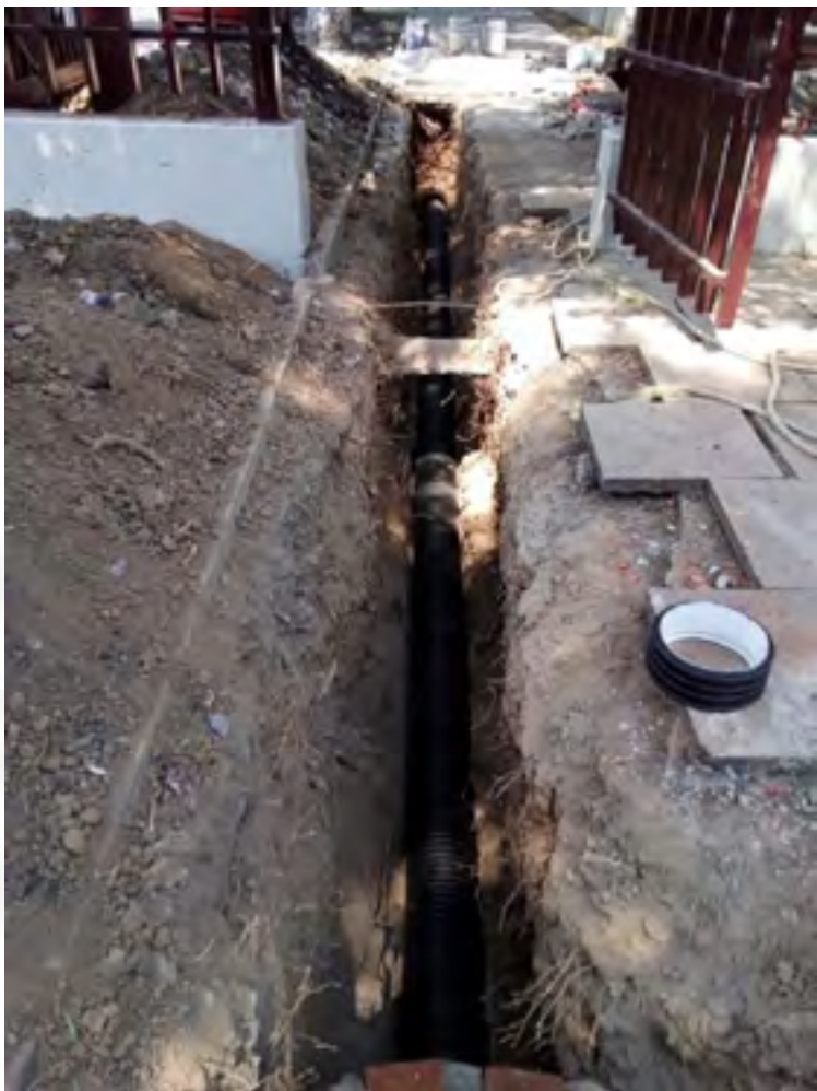
Mantenimiento a la red sanitaria
