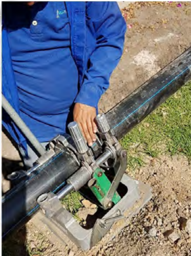
Mantenimiento a la red
