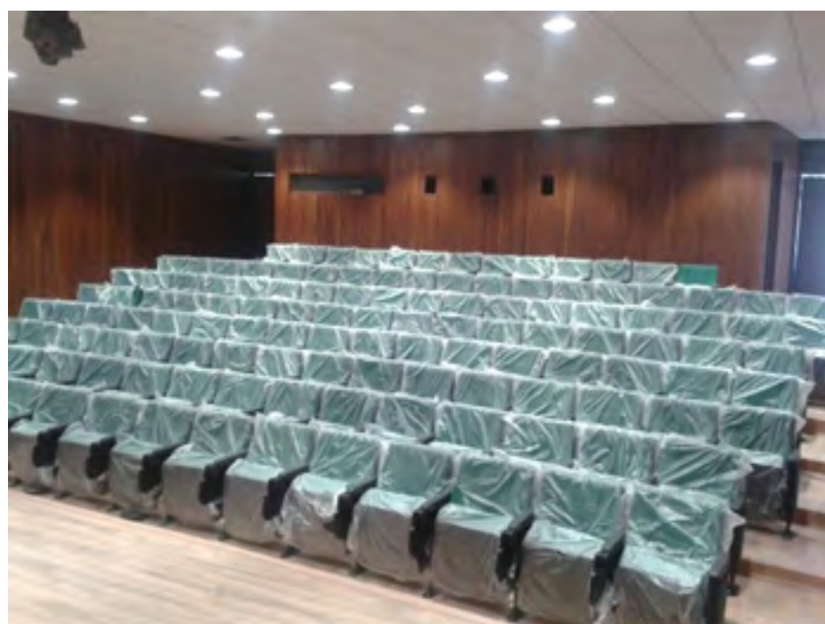
Sustitución de butacas, luminarias, pisos y plafón
