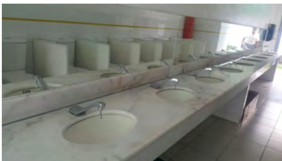
Sustitución de lavabos
