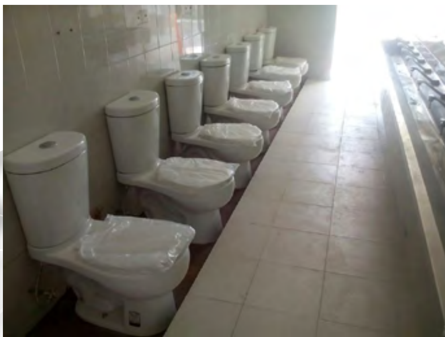
Sustitución de muebles sanitarios, accesorios pisos y lambrines
