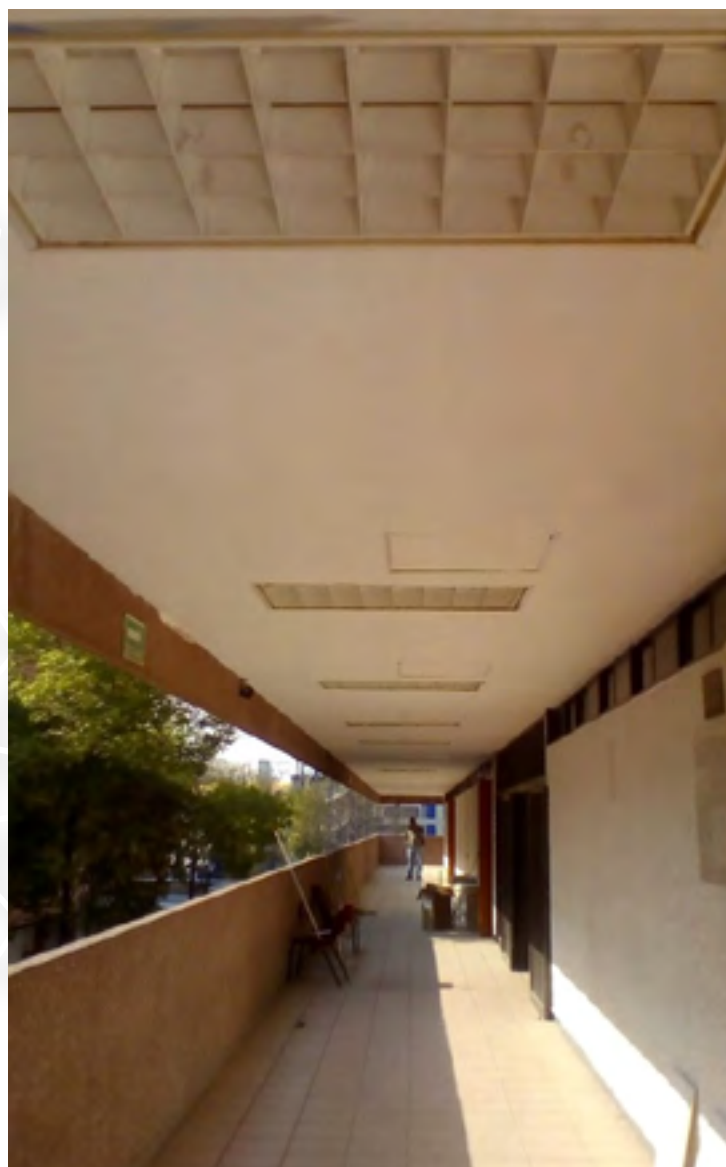
Sustitución de plafón en pasillo
