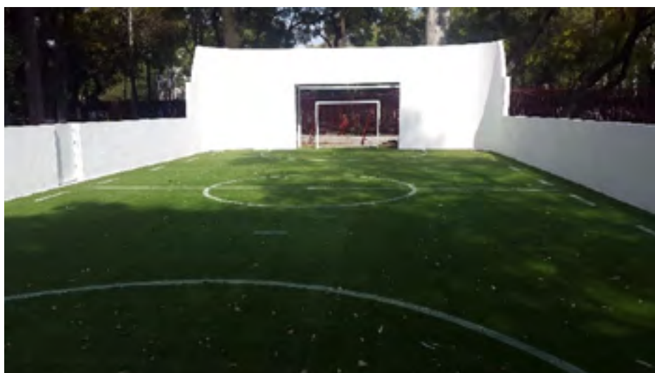
Trabajos complementarios en cancha de fútbol
