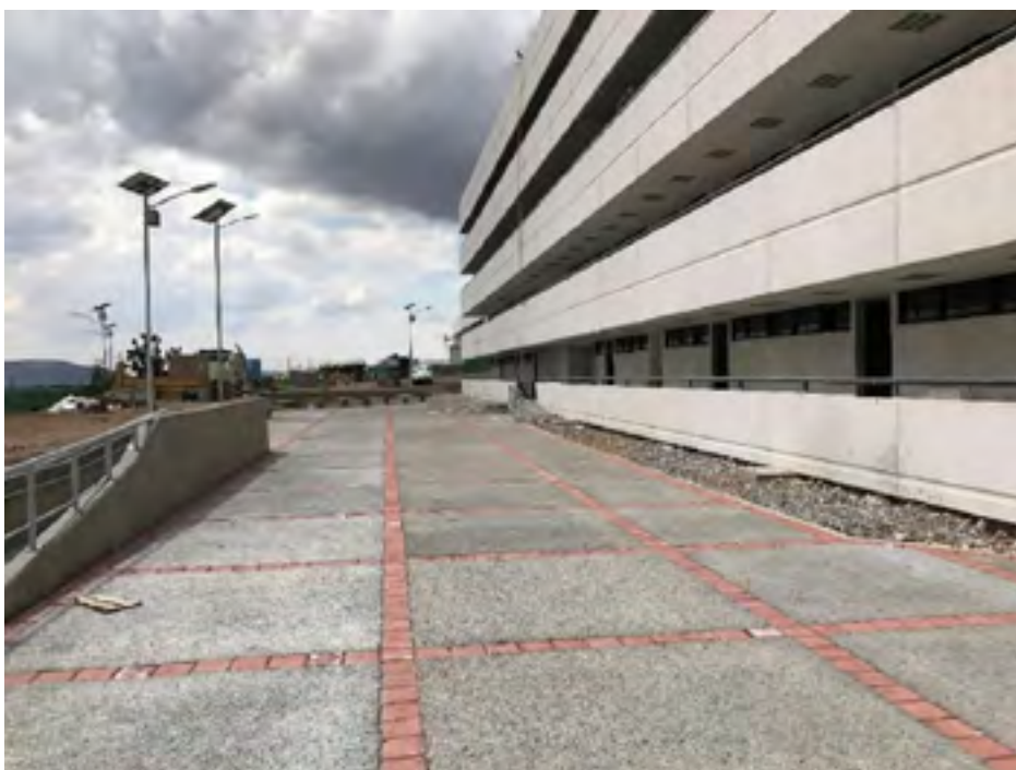
Obra exterior, andadores
