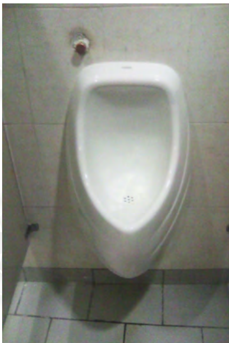
Mantenimiento preventivo en muebles sanitarios
