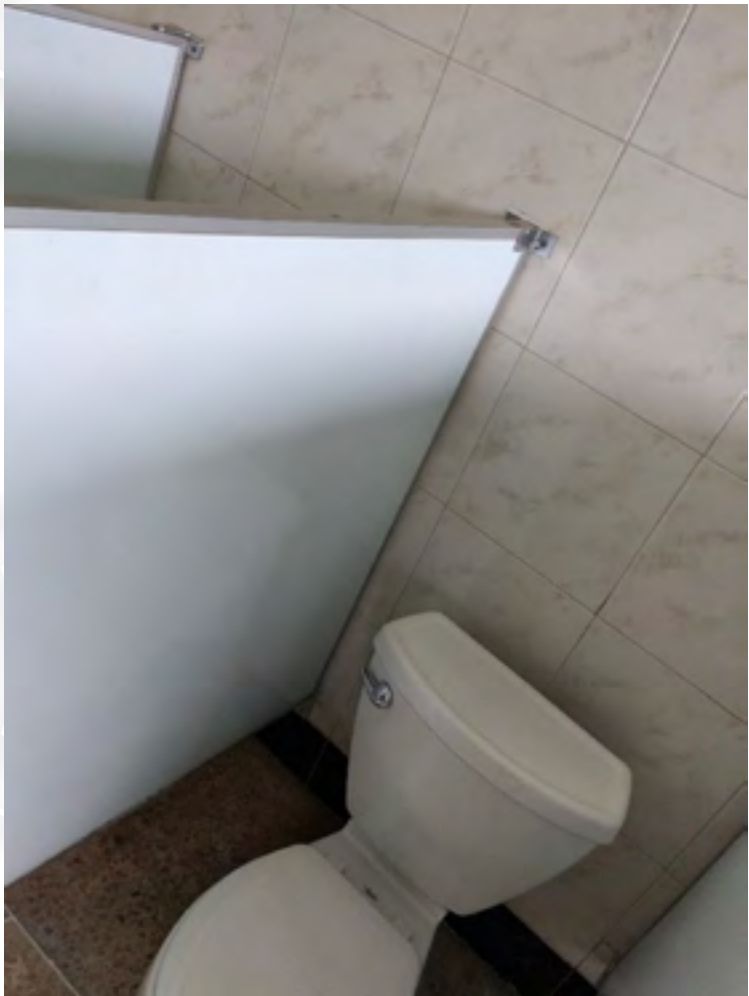
Sustitución de muebles sanitarios
