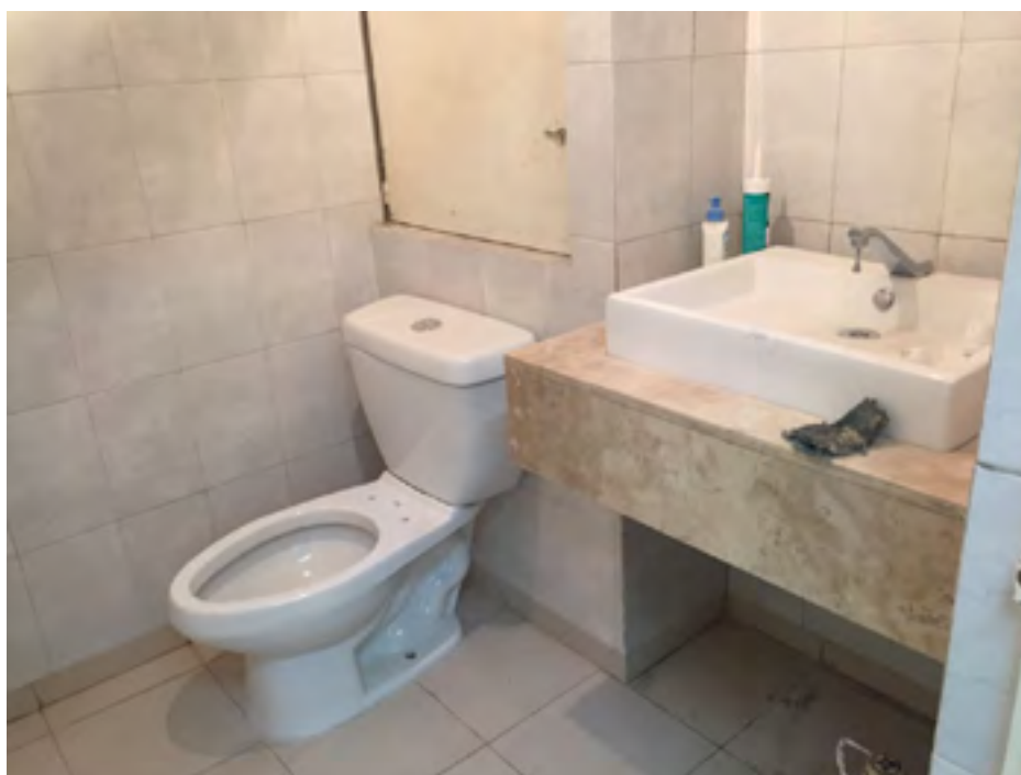
Sustitución de muebles sanitarios y accesorios
