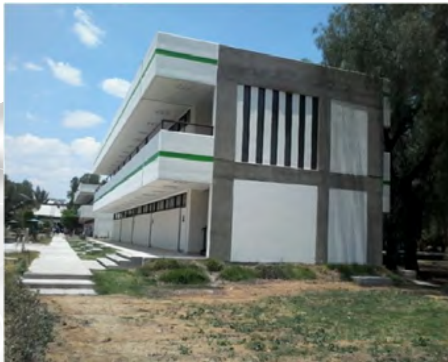
Perspectiva de edificio vista desde zona de acceso
