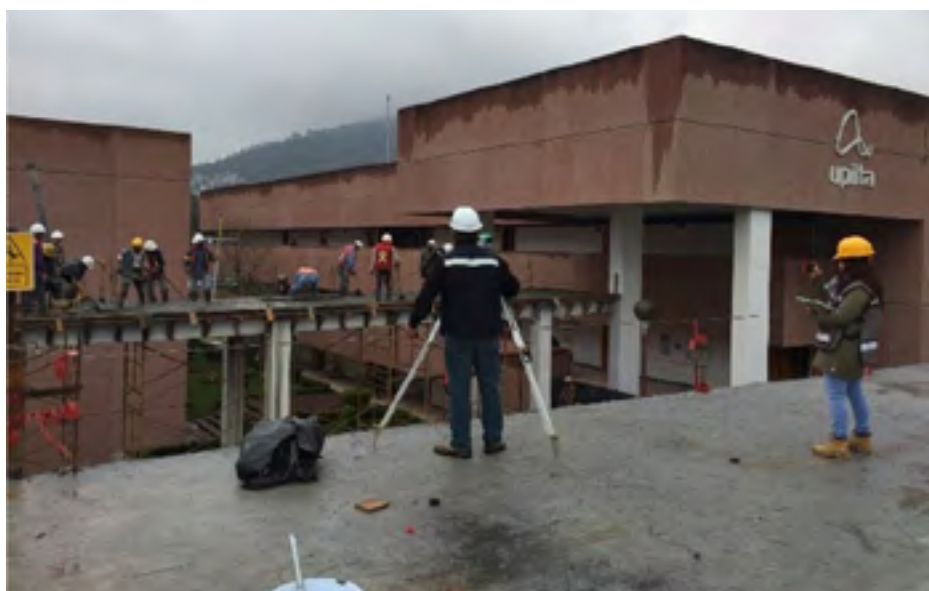
Supervisión de los trabajos de topografía
