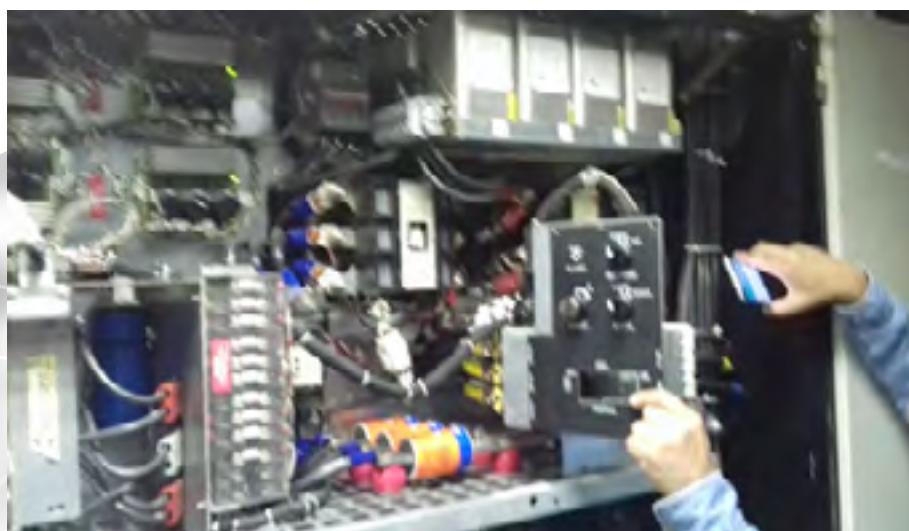
Mantenimiento a Unidades de Energía Ininterrumpida
