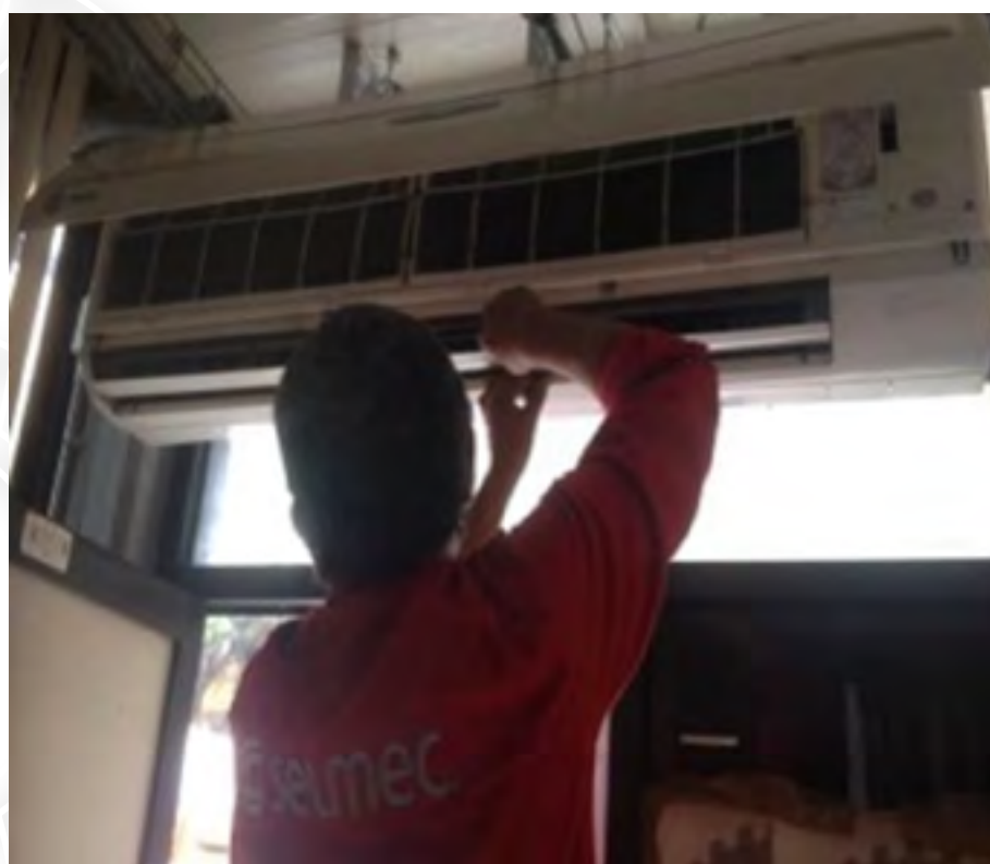
Mantenimiento aires acondicionados
