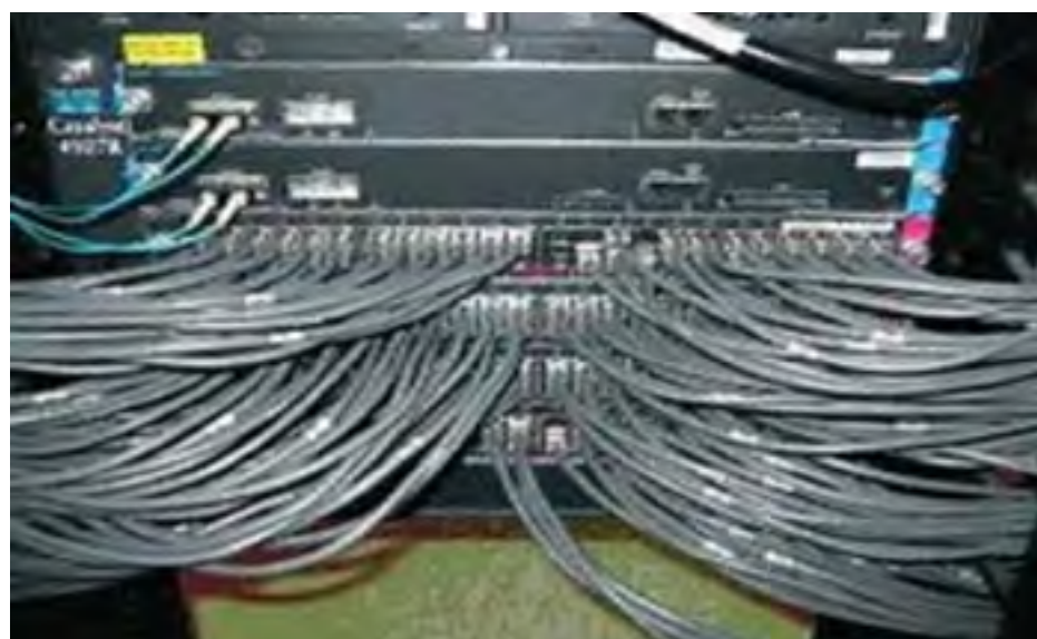
Modernización cableado estructurado
